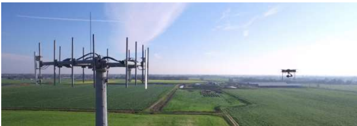
Slika 25. Dronovi u službi pregleda telekomunikacijskih tornjeva, [27].
