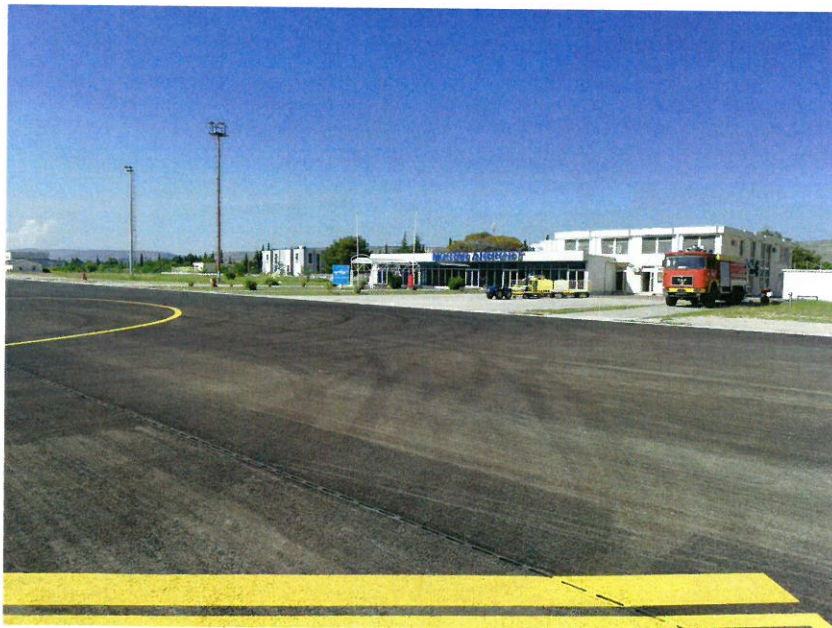
Slika 10. Obnovljena stajanka na ZLM
