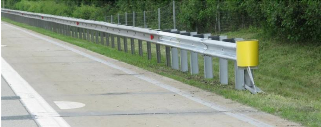
Slika 7.: Zaštitna ograda na cesti, [11]
