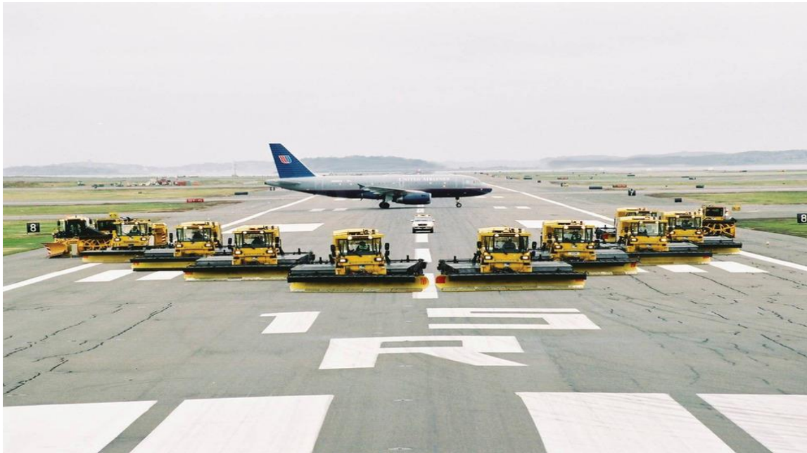
Slika 9. Postupak mehaničkog čišćenja konstruktivnih kolničkih površina [21]
