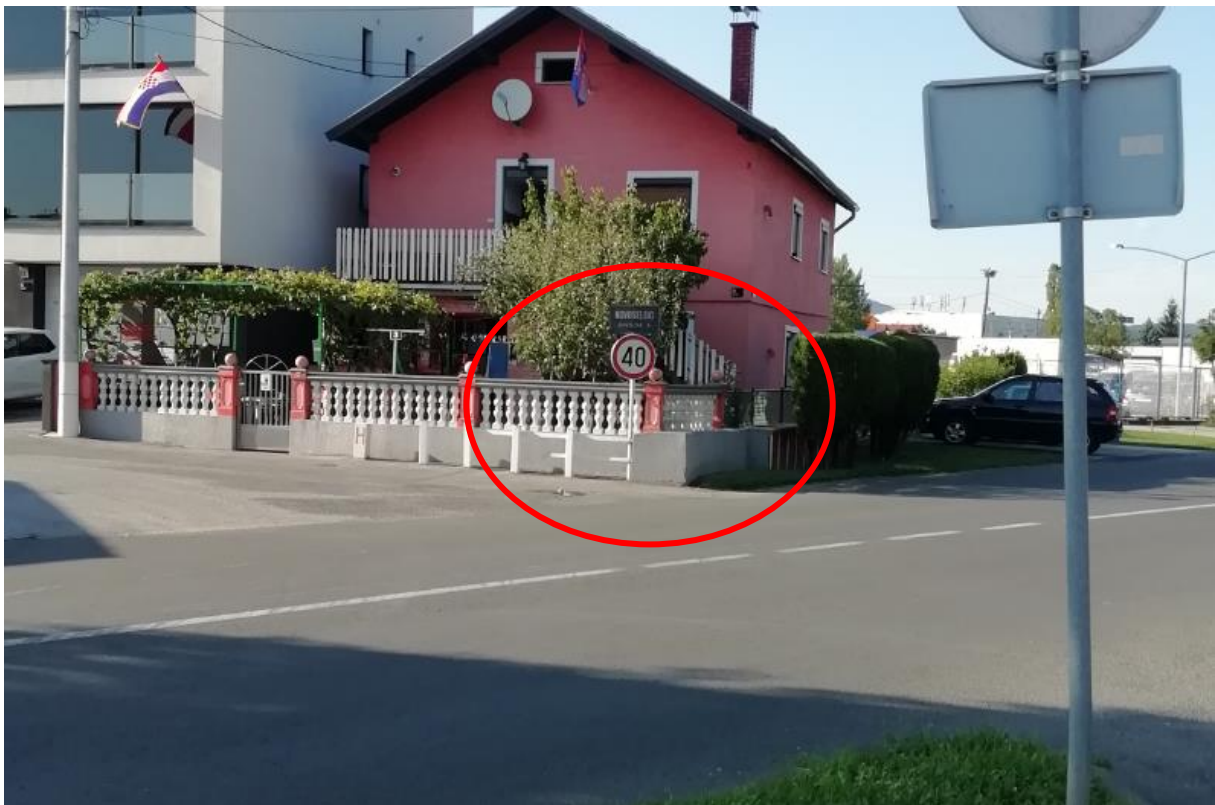
Slika 20. Prikaz potencijalno opasnog krutog elementa smještenog uz rub ceste (betonska ograda) na Raskrižju 1
