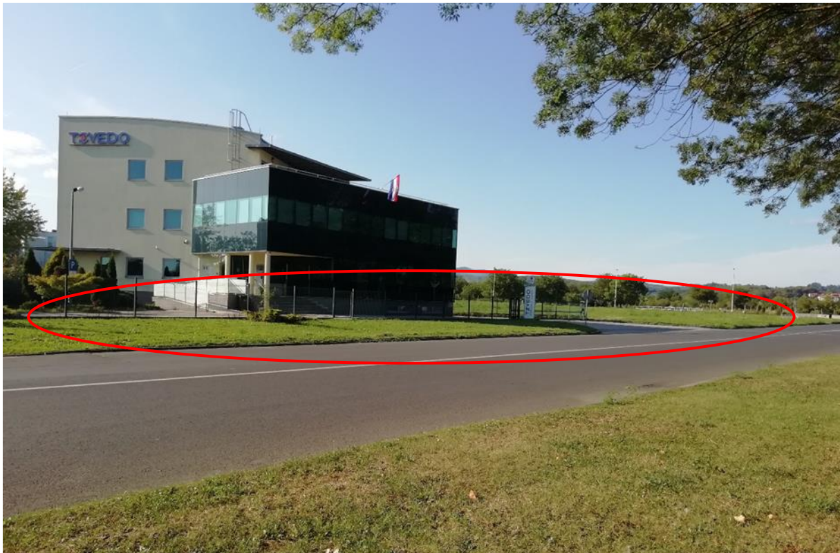
Slika 23. Prikaz nedostatka nogostupa
