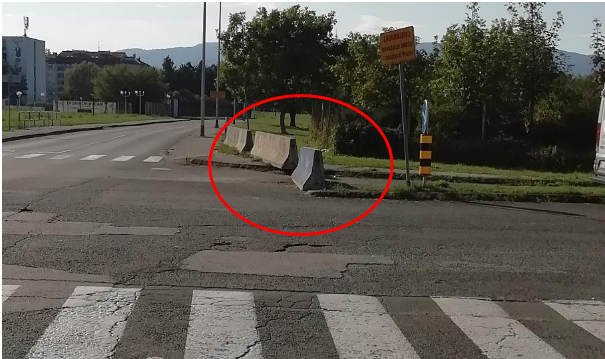
Slika 19. Prikaz potencijalno opasnog krutog elementa smještenog uz rub ceste (New Jersey ograda) na Raskrižju 2
