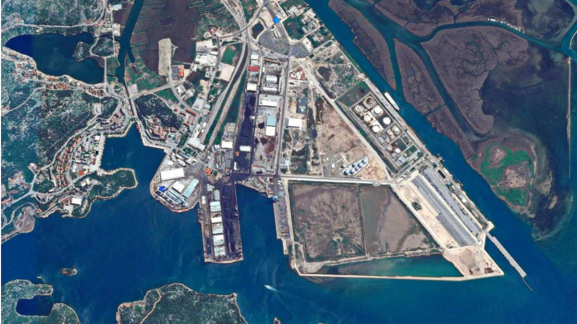
Slika 7. Port of Ploče
