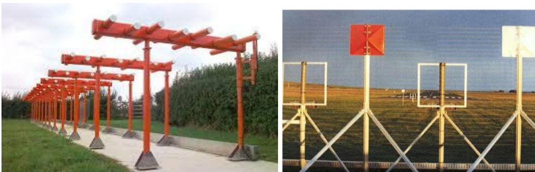
Slika 5. Primjer log-periodske antene i četvrtaste antene. [4]
