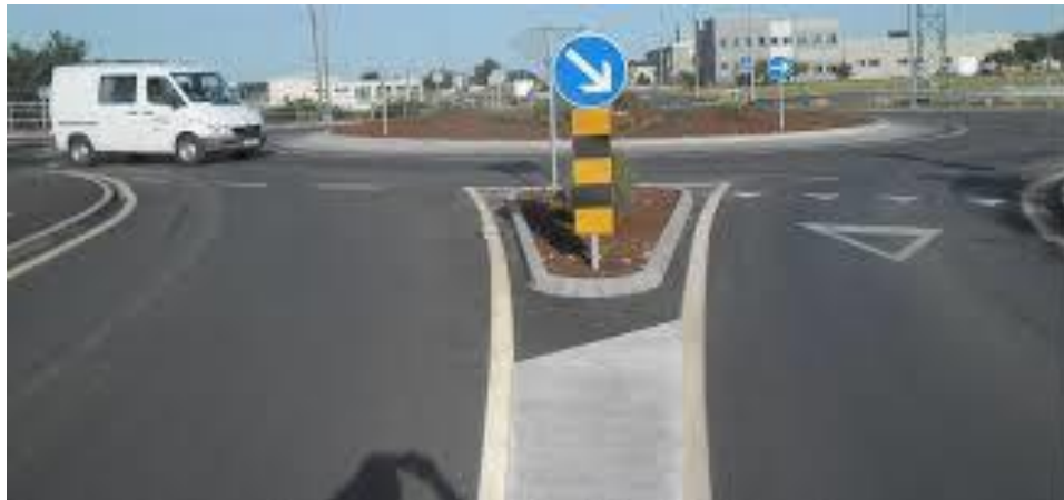
Slika 9. Razdjelni otok unutar površine za razdvajanje prometa
