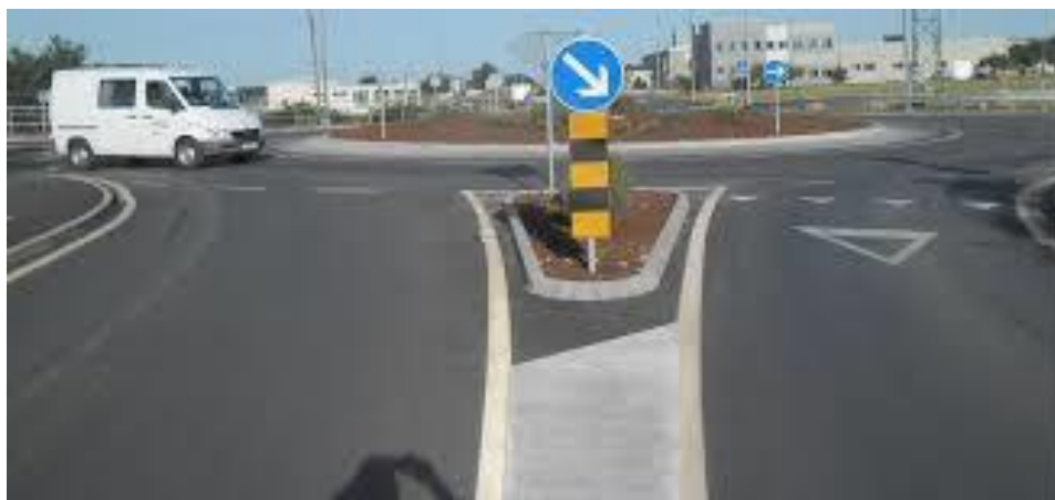
Slika 9. Razdjelni otok unutar površine za razdvajanje prometa
