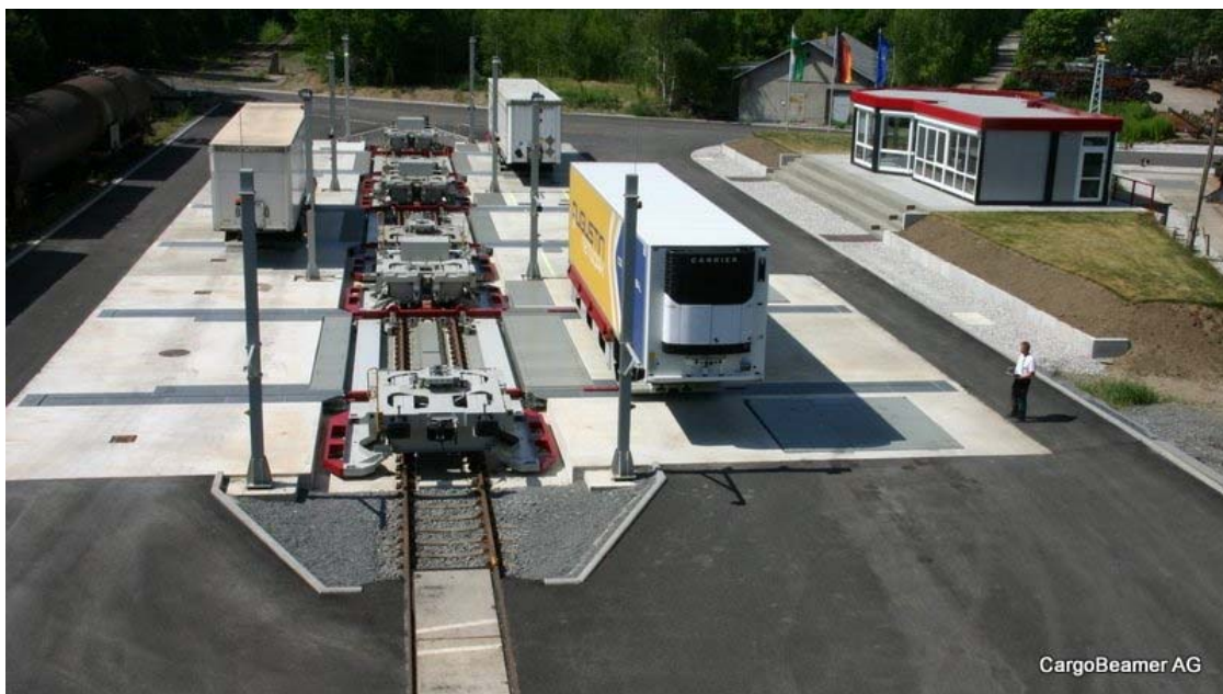
Slika 19. Prikaz CargoBeamer paralelnog utovara i istovara
