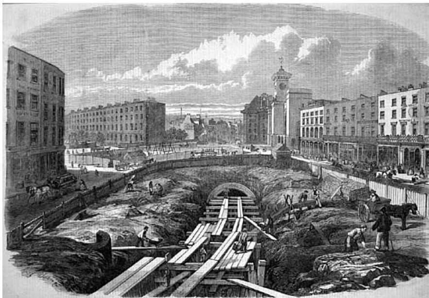
Slika 3. Iskapanje tunela namijenjenih Metropolitan Railwayu, 1861. Godine [15]
