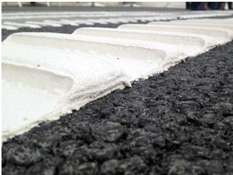
Slika 6. Profilirana oznaka izrađena od plastike
