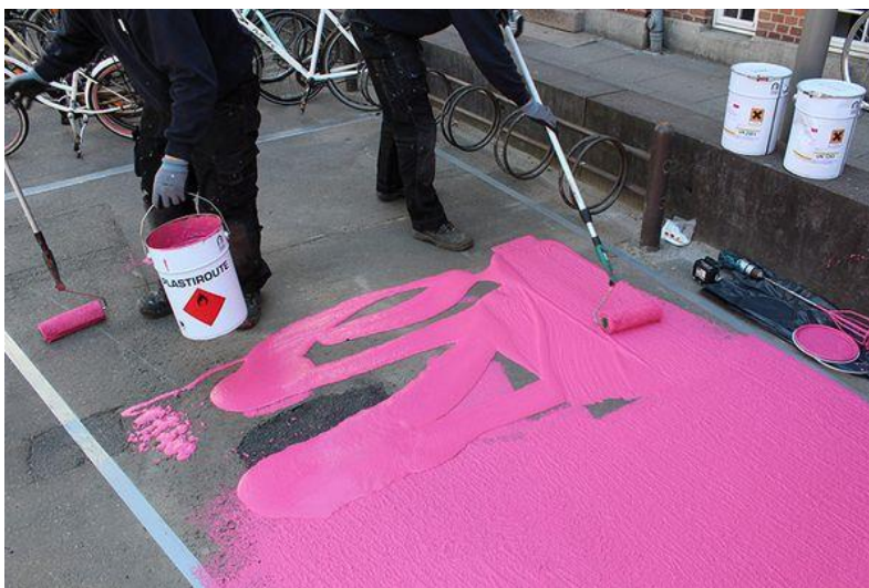
Slika 7. Ručno postavljanje hladne plastike
