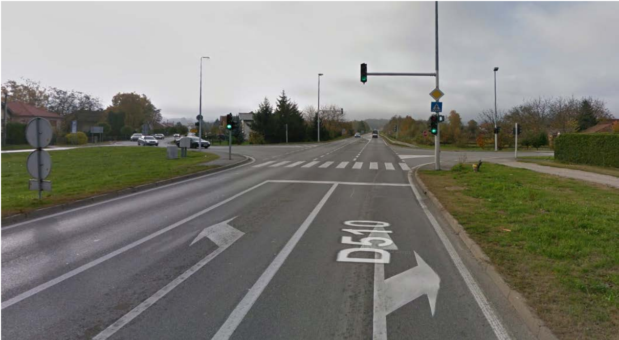
Slika 35. Prikaz glavnog smjera kretanja sa posebnim trakom za lijevo skretanja [24]
