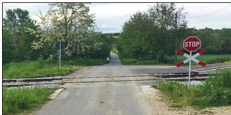
Slika 7. Pasivno osiguran željezničko-cestovni prijelaz
