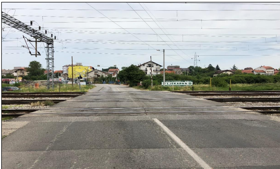
Slika 17. Pogled na ŽCP „B1“ u smjeru sjevera
