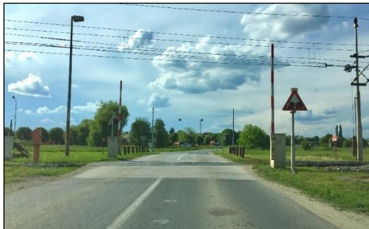
Slika 12. Željezničko-cestovni prijelaz osiguran polubranicima
