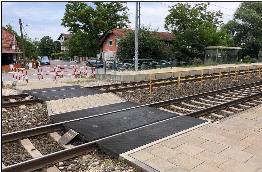
Slika 26. Podloga na pješačkom prijelazu i zaštitna ograda
