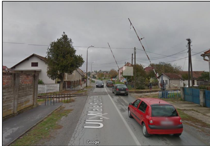
Slika 13. Željezničko-cestovni prijelaz osiguran branicima [9]
