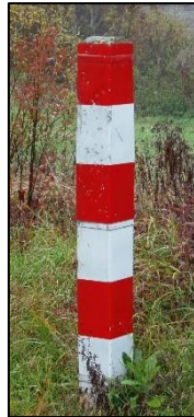
Slika 8. Opomenica željezničko-cestovnih prijelaza
