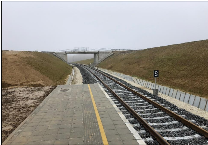
Slika 1. Križanje željezničke pruge i ceste izvan razine
