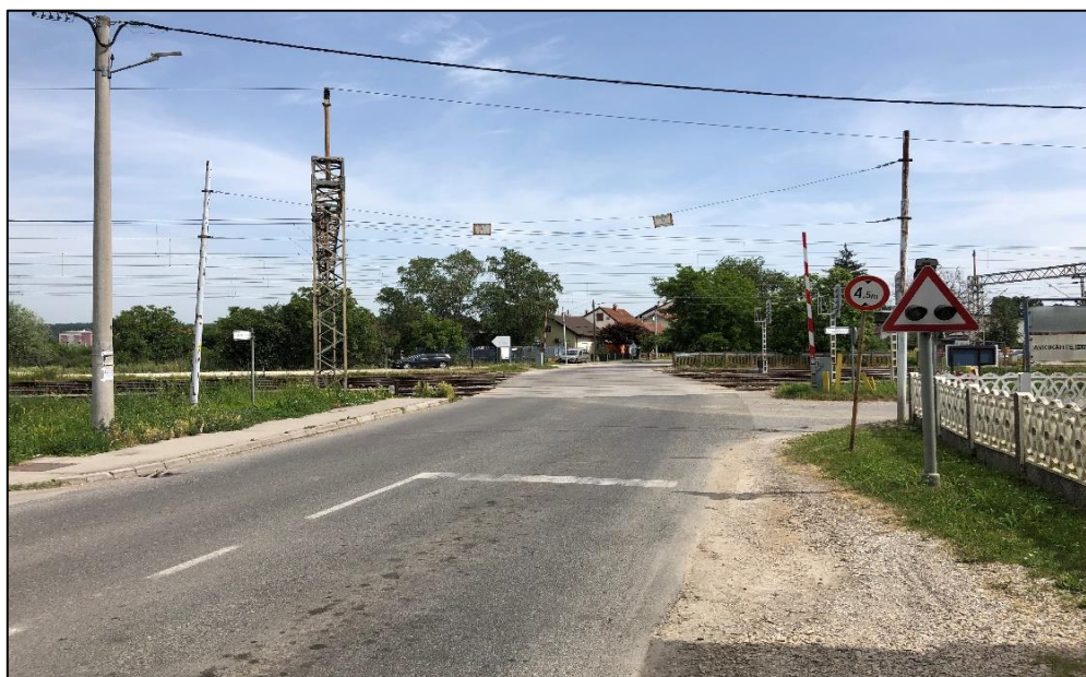
Slika 30. Pogled na ŽCP „B2“ u smjeru sjevera
