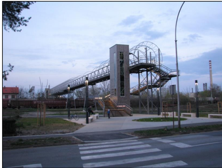
Slika 2. Križanje željezničke pruge i pješačke staze izvan razine [3]
