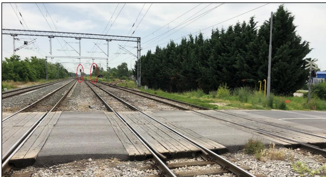
Slika 18. Položaj izlaznih signala u smjeru Dugog Sela/pogled na borove koji zaklanjaju preglednost
