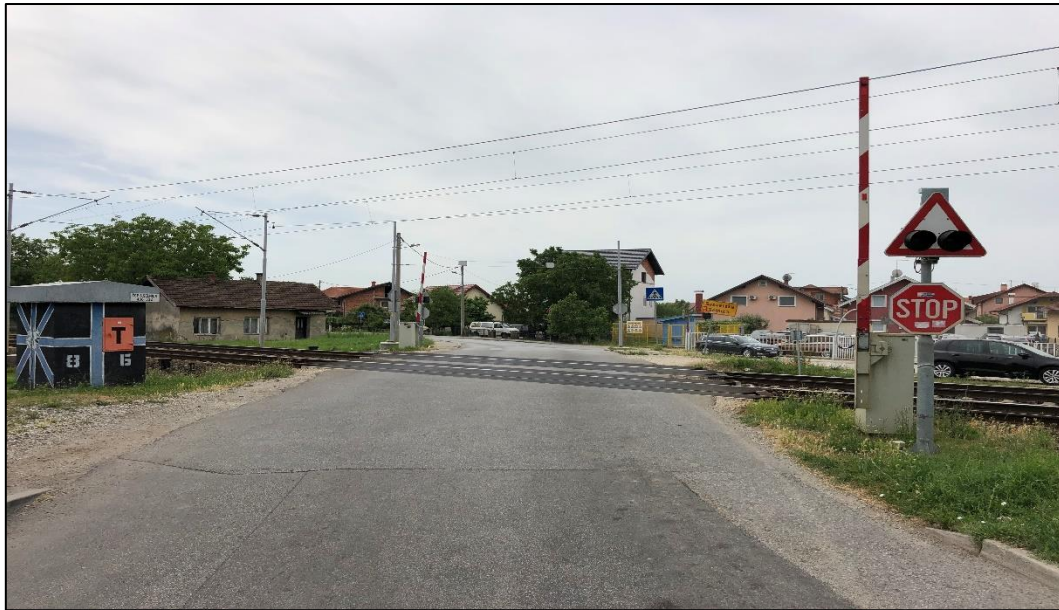
Slika 19. Željezničko-cestovni prijelaz „Sesvetska Selnica“ – pogled prema jugu
