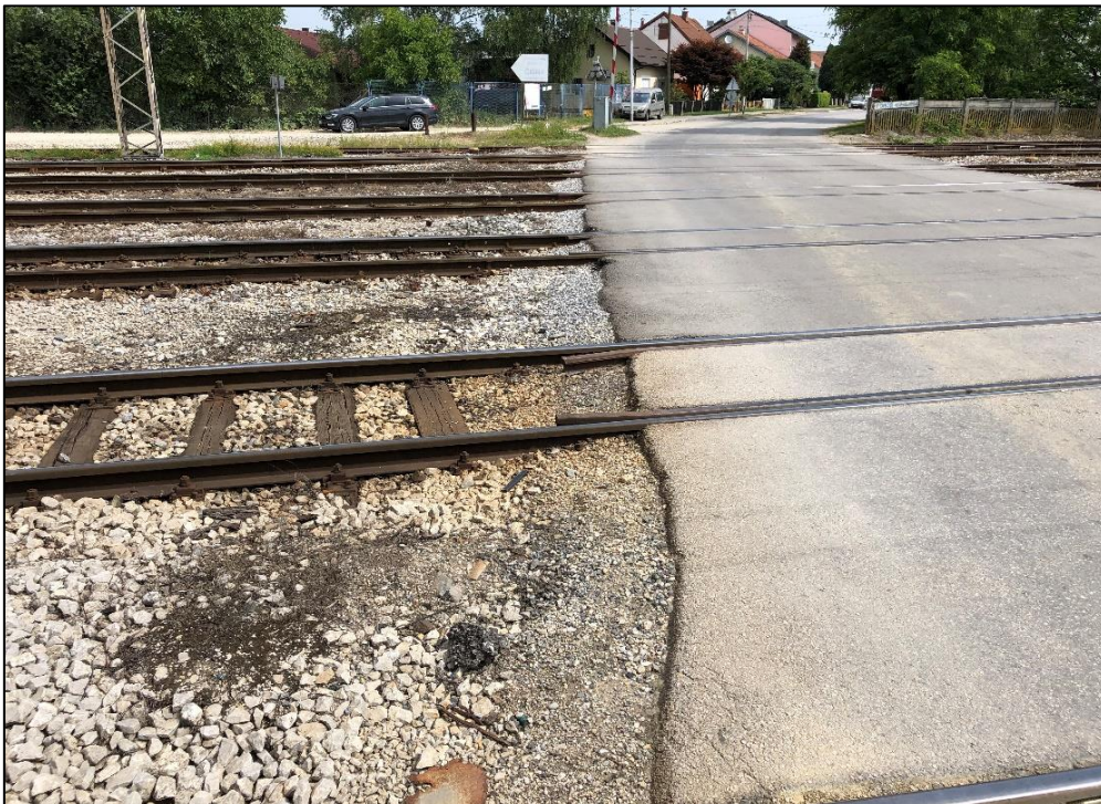
Slika 34. Stanje podloge na ŽCP-u „B2“
