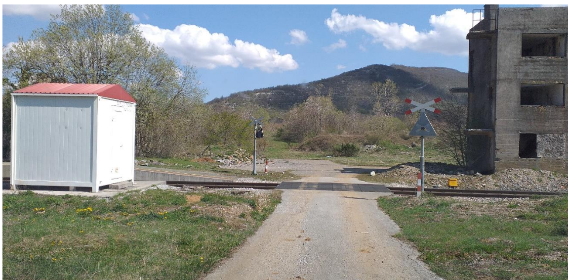
Slika 29. Željezničko-cestovni prijelaz Ličko Cerje-rudnik iz smjera juga
