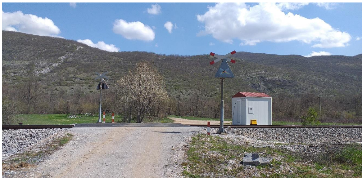
Slika 35. Željezničko-cestovni prijelaz Peršići iz smjera juga
