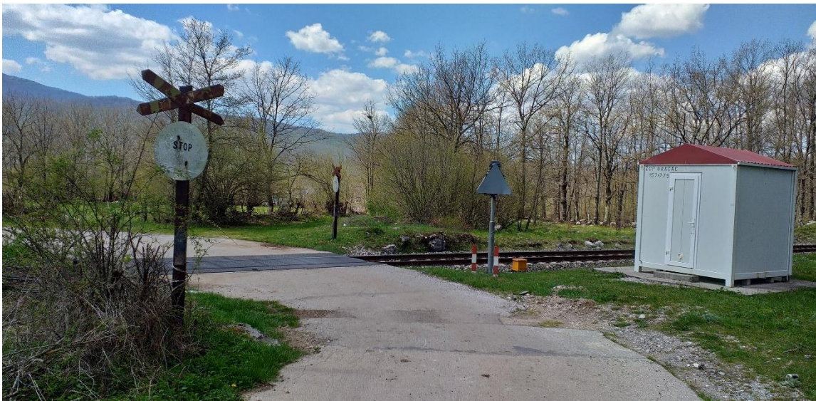
Slika 47. Željezničko-cestovni prijelaz Gračac iz smjera sjevera
