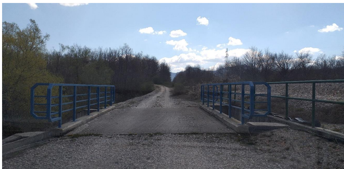
Slika 42. Most i prilazna cesta do ukinutog željezničko-cestovnog prijelaza
