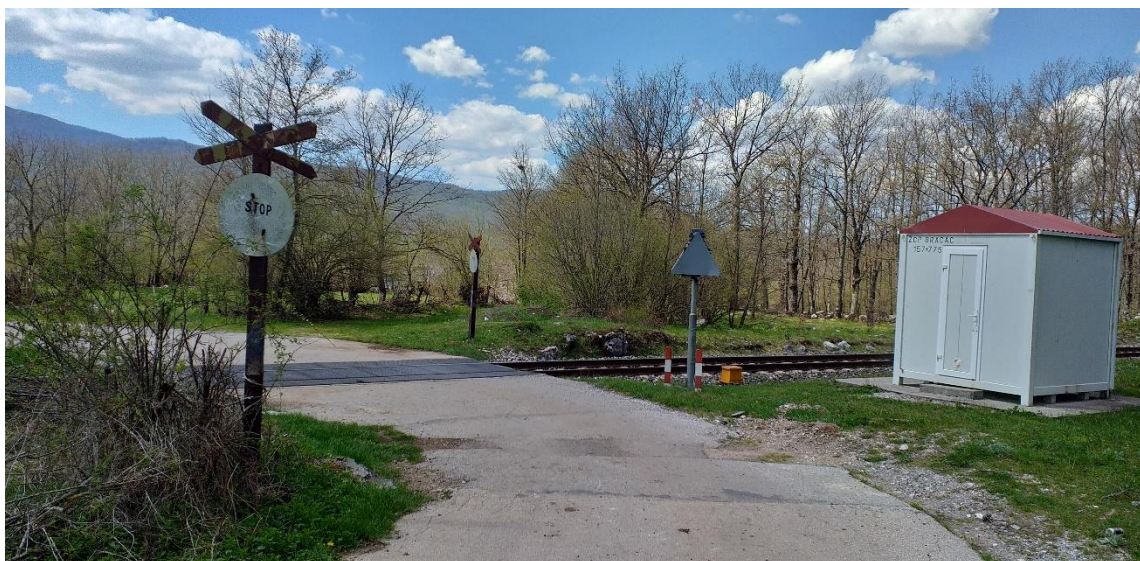
Slika 47. Željezničko-cestovni prijelaz Gračac iz smjera sjevera
