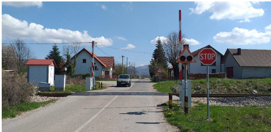
Slika 3. Primjer željezničko-cestovnog prijelaza u istoj razini
