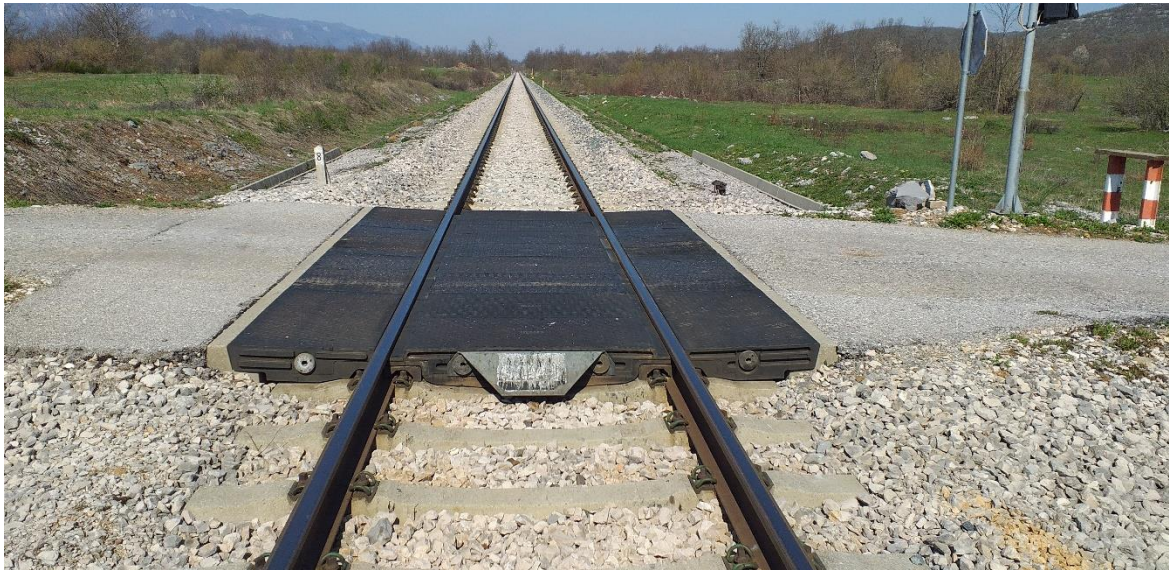
Slika 33. Podloga tvrtke „STRAIL“ na ŽCP-u Ričice
