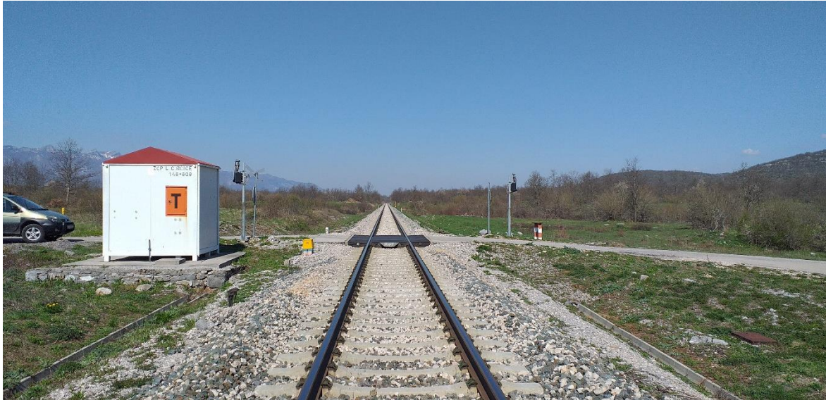
Slika 34. Kućica sa uređajem ŽCP-a ometa preglednost na prugu
