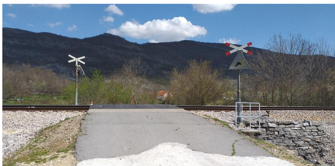
Slika 46. Željezničko-cestovni prijelaz Štikada iz smjera juga
