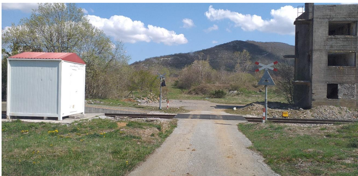
Slika 29. Željezničko-cestovni prijelaz Ličko Cerje-rudnik iz smjera juga
