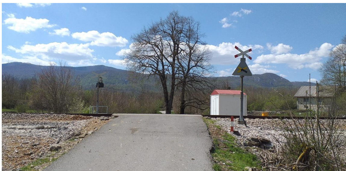
Slika 45. Željezničko-cestovni prijelaz Štikada iz smjera sjevera
