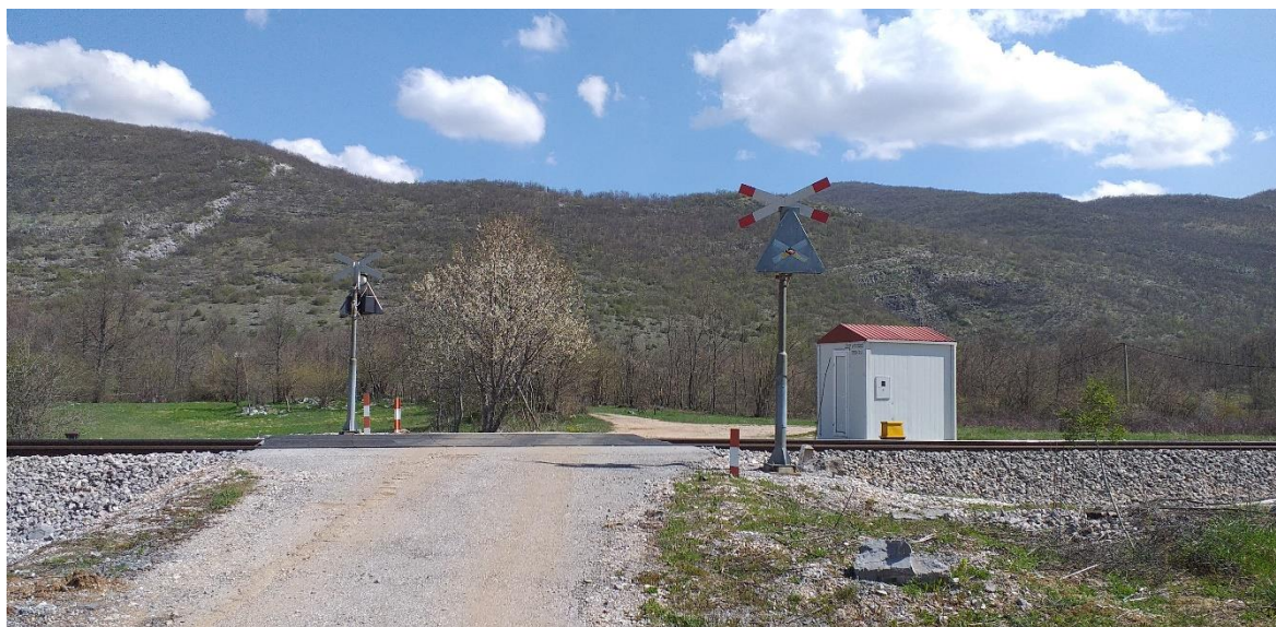
Slika 35. Željezničko-cestovni prijelaz Peršići iz smjera juga
