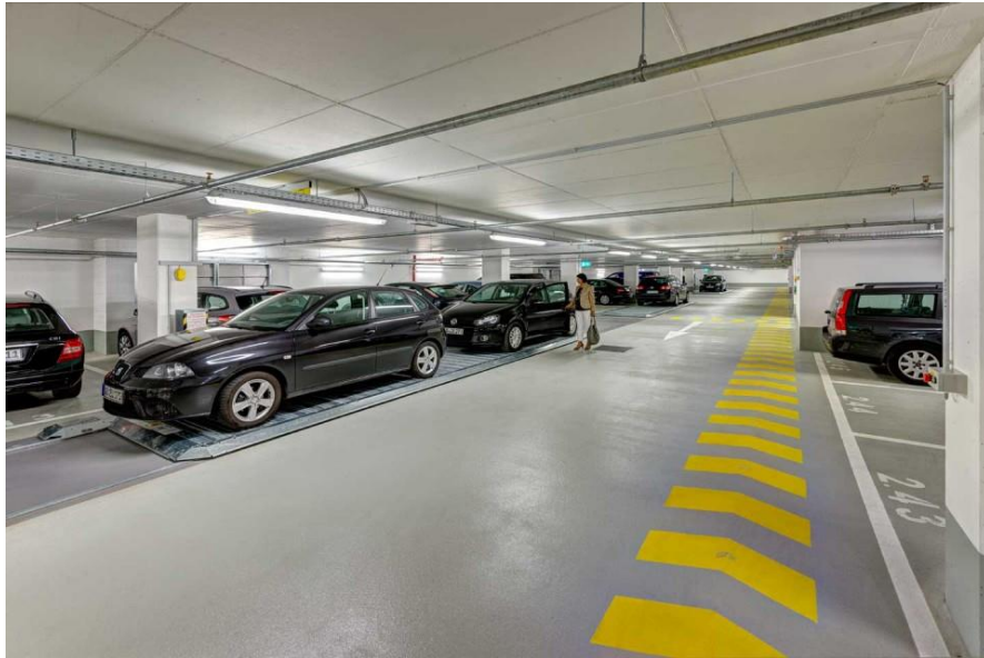
Slika 21. Potpuno mehanizirana garaža s horizontalnom platformom; [9]
