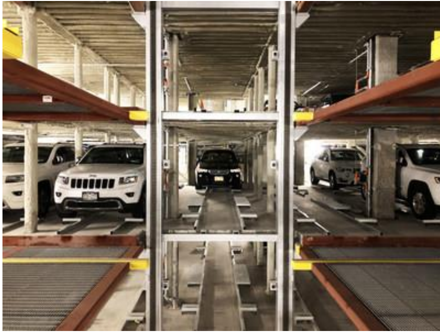
Slika 23. Dizalo u kombinaciji sa horizontalnom platformom; [11]
