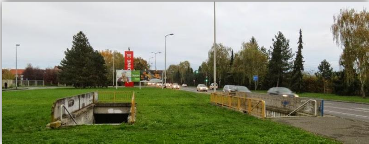
Slika 7. Pothodnik za pješake na stanici Mlinar
