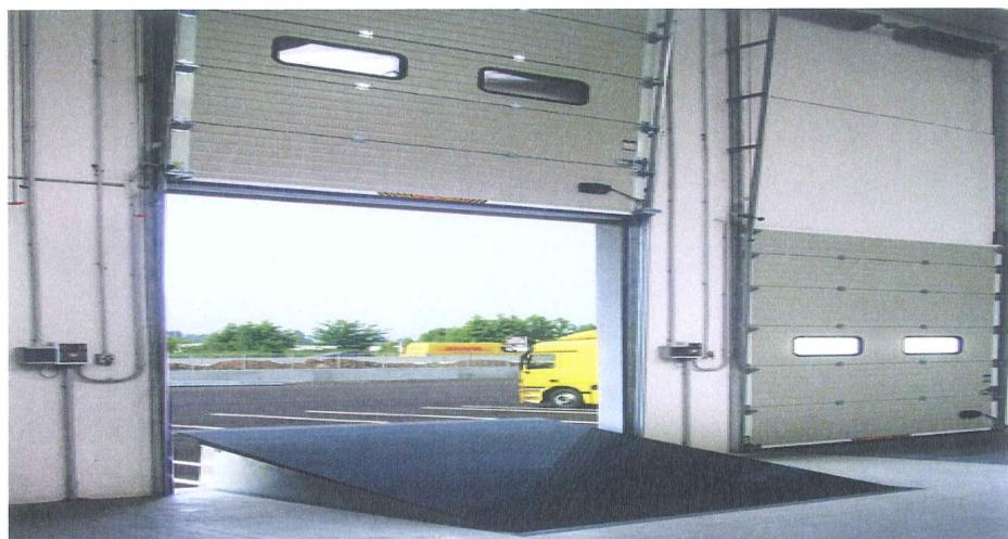
Slika 29: Hidraulična rampa
