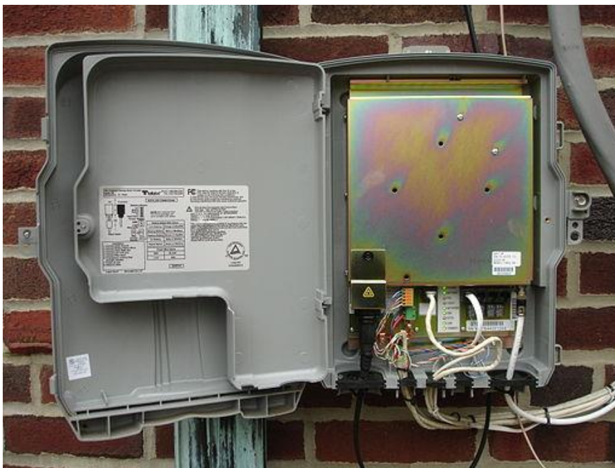
Slika 12. Optički mrežni terminal, [22]
