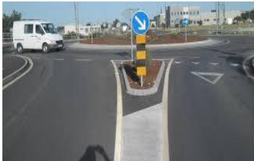
Slika 5. Razdjelni otok unutar površine za razdvajanje prometa
