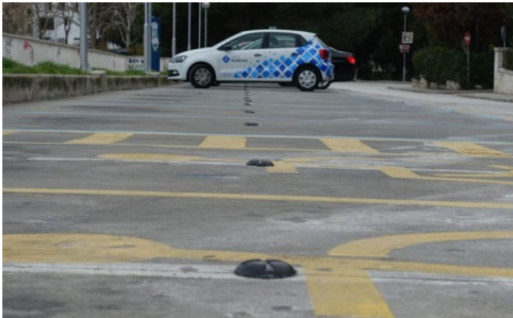
Slika 6.7. Parkirališni senzori ugrađeni u gradu Splitu
