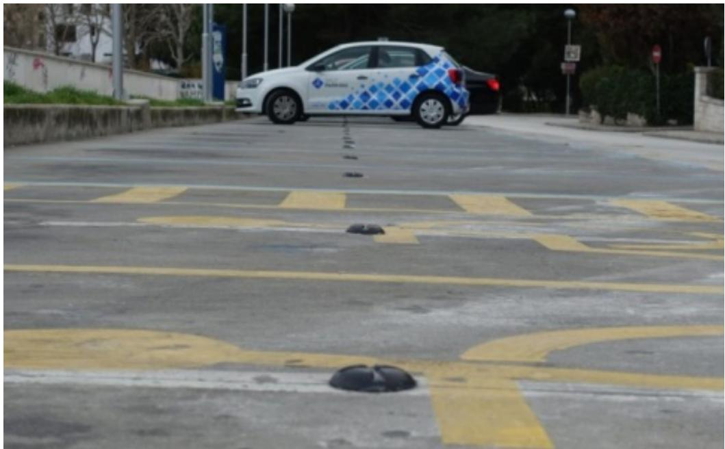
**Slika 6.7. Parkirališni senzori ugrađeni u gradu Splitu**
