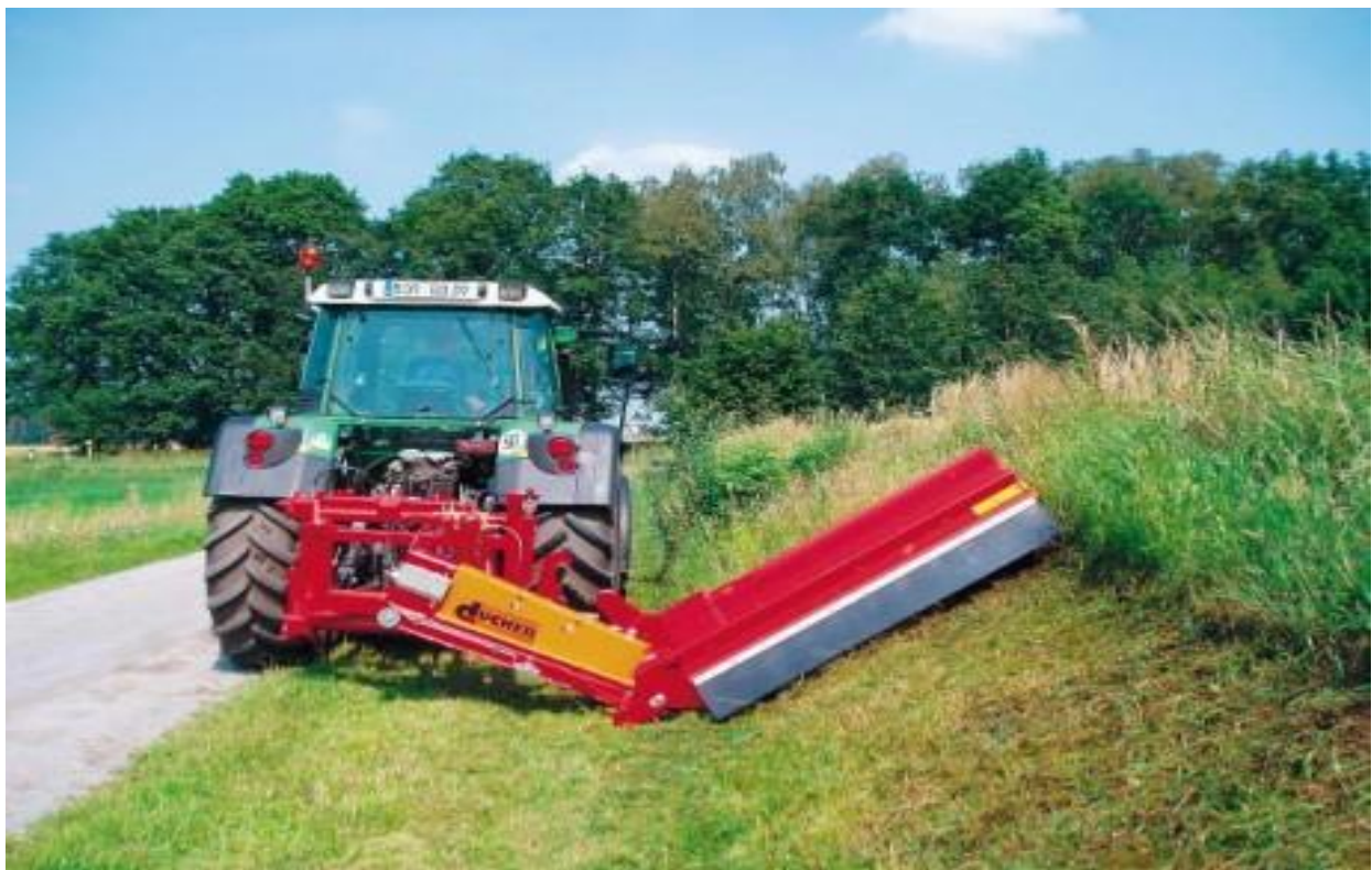
Slika 11. Radovi na uređenju vegetacije
