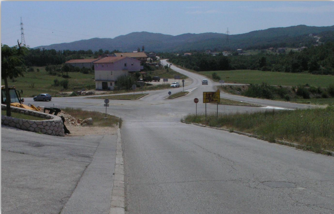
Slika 5. Sjeverni privoz raskrižju
