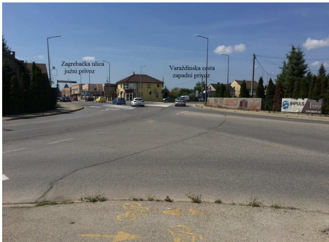
Slika 14. Pogled na raskrižje Zagrebačke ulice i Varaždinske ceste sa sjevernog privoza
