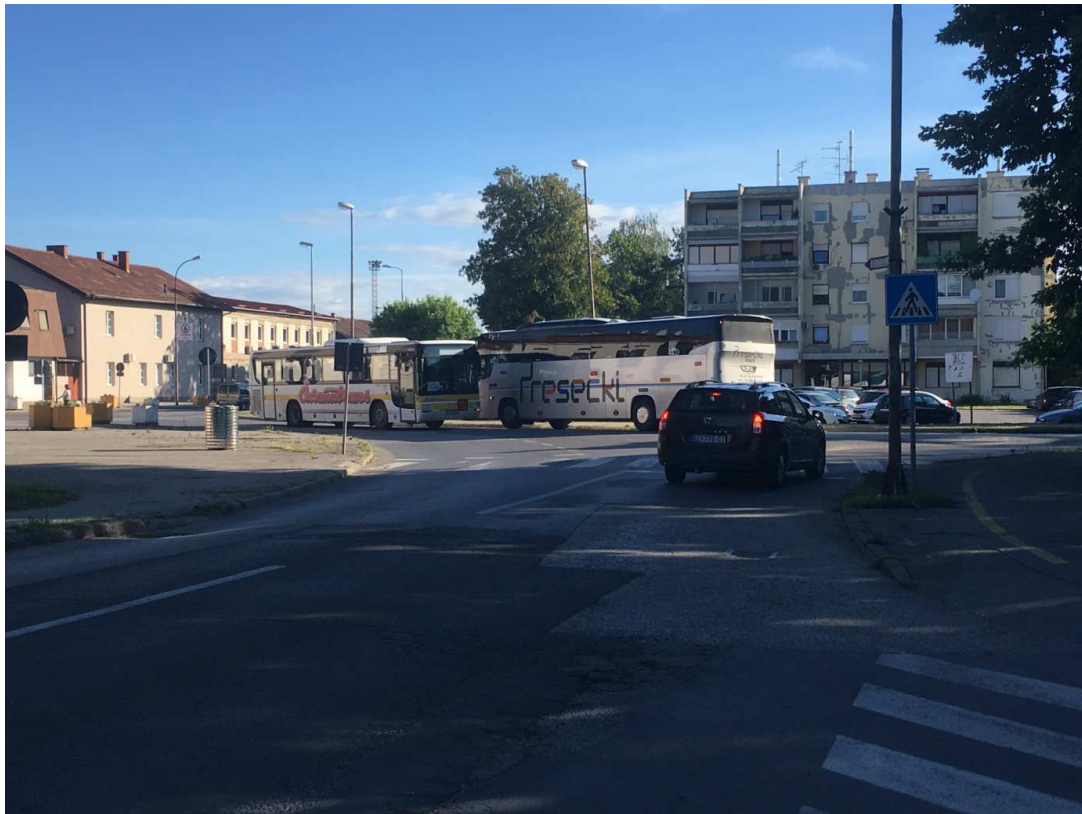
Slika 18. Poteškoče prilikom mimoilaženja dva autobusa na raskrižju Kolodvorske ulice i Ulice Ivana Meštrovića
