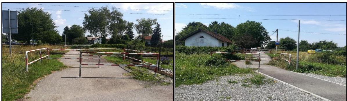
Slika 121. Željezničko-cestovni prijelaz „Ul. Mlad.“ iz smjera zapada Slika 122. Željezničko-cestovni prijelaz „Ul. Mlad.“ iz smjera istoka
