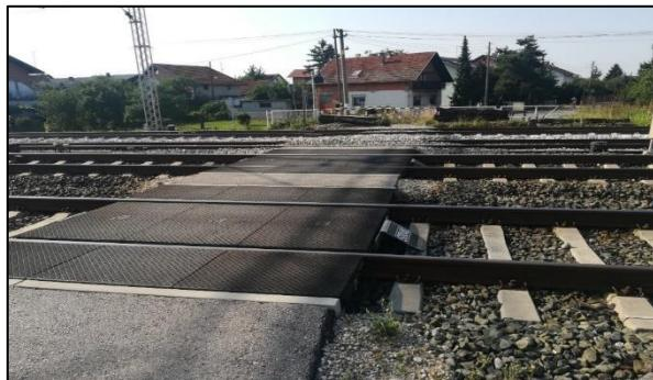
Slika 35. Prikaz stanja gumiranih ploča na željezničko-cestovnom prijelazu „Treska“
