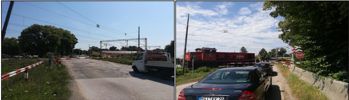
Slika 109. Željezničko-cestovni prijelaz „Horvatova“ iz smjera zapada Slika 110. Željezničko-cestovni prijelaz „Horvatova“ iz smjera istoka
