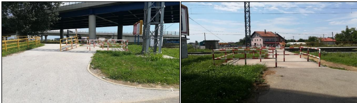
Slika 125. Željezničko-cestovni prijelaz „Odra St.“ iz smjera zapada Slika 126. Željezničko-cestovni prijelaz „Odra St.“ iz smjera istoka
