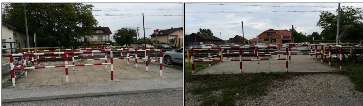
Slika 57. Željezničko-cestovni prijelaz „St. Kralj.“ iz smjera sjevera Slika 58. Željezničko-cestovni prijelaz „St. Kralj.“ iz smjera juga
