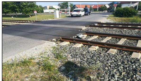
Slika 63. Prikaz stanja gumirane podlage na željezničko-cestovnom prijelazu „Retkovac 3“
