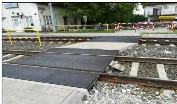
Slika 59. Prikaz stanja gumirane podloge na željezničko-cestovnom prijelazu „Stajalište Kraljevac“
