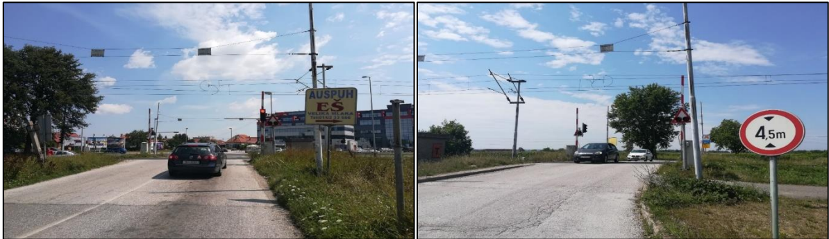
Slika 117. Željezničko-cestovni prijelaz „Buzin“ iz smjera zapada Slika 118. Željezničko-cestovni prijelaz „Buzin“ iz smjera istoka
