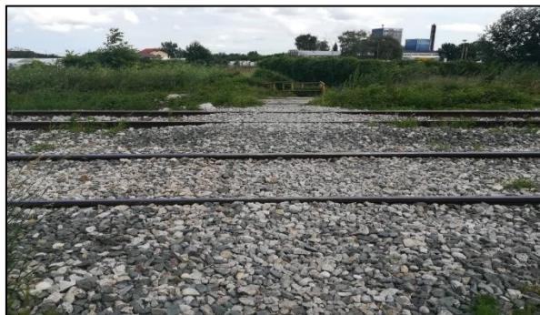
*Slika 141. Prikaz stanja kamene podloge na željezničko-cestovnom prijelazu „Resnik“*
