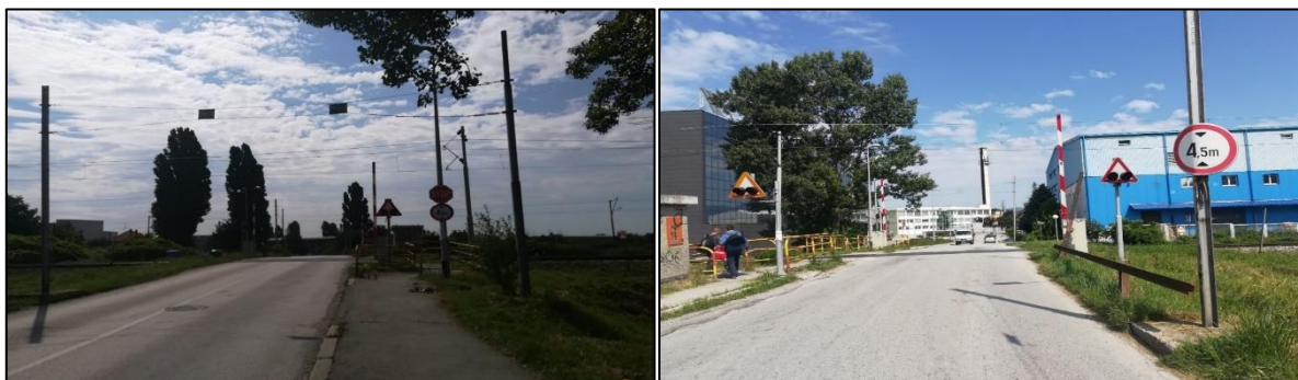
Slika 97. Željezničko-cestovni prijelaz „Savski Gaj“ iz smjera sjevera Slika 98. Željezničko-cestovni prijelaz „Savski Gaj“ iz smjera juga
