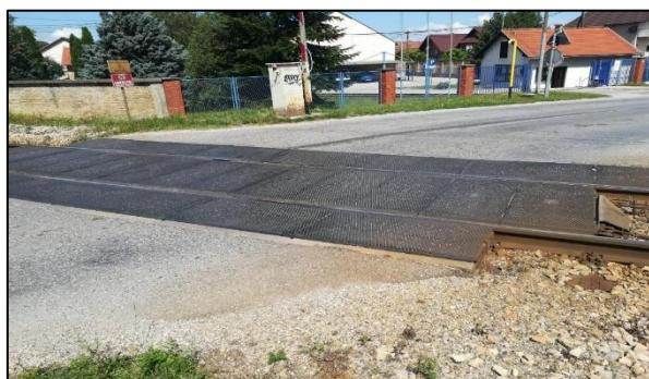
Slika 79. Prikaz stanja gumirane podloge na željezničko-cestovnom prijelazu „Bedekova“
