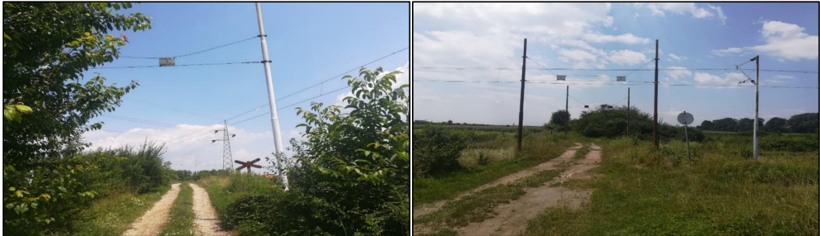
Slika 133. Željezničko-cestovni prijelaz „Polj. put“ iz smjera zapada Slika 134. Željezničko-cestovni prijelaz „Polj. put“ iz smjera istoka
