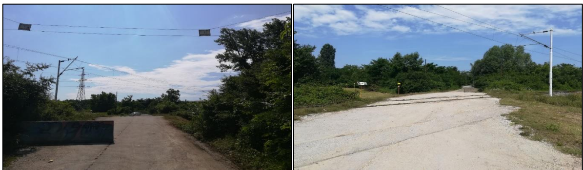
Slika 113. Željezničko-cestovni prijelaz „Horvat. 2“ iz smjera zapada Slika 114. Željezničko-cestovni prijelaz „Horvat.2“ iz smjera istoka
