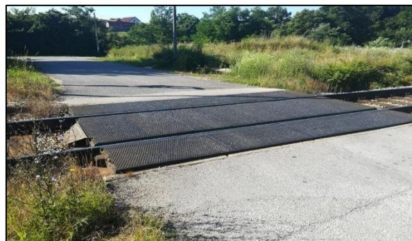
Slika 67. Prikaz stanja gumirane podloge na željezničko-cestovnom prijelazu „Horvati“
