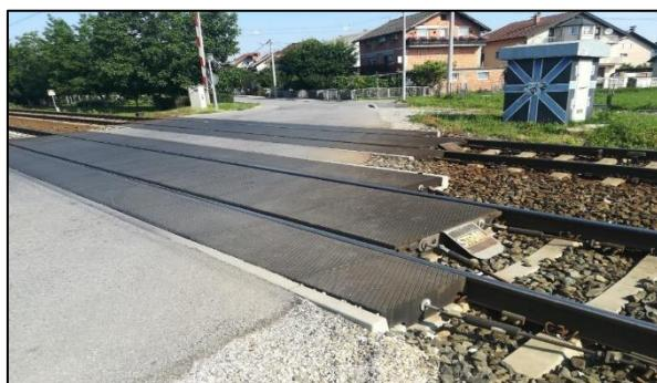
Slika 47. Prikaz stanja gumirane podloge na željezničko-cestovnom prijelazu „Selnica“
