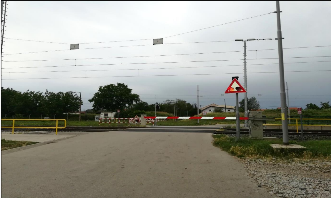
Slika 8. Željezničko-cestovni prijelaz „Trnava“ iz smjera sjevera
