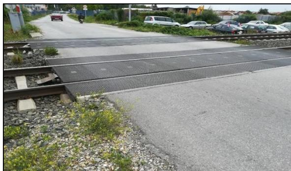
Slika 51. Prikaz stanja gumirane podloge na željezničko-cestovnom prijelazu „Staklana“
