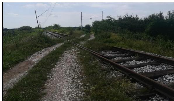
*Slika 135. Prikaz stanja kamene podloge na željezničko-cestovnom prijelazu „Poljski put“*
