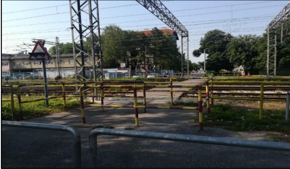
Slika 37. Željezničko-cestovni prijelaz „Sljeme“ iz smjera sjevera
