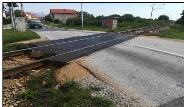
Slika 91. Prikaz stanja gumirane podloge na željezničko-cestovnom prijelazu „Brezovečka“
