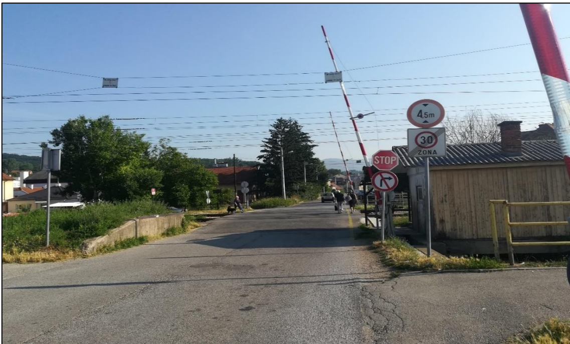
Slika 26. Željezničko-cestovni prijelaz „Sokolska“ iz smjera juga
