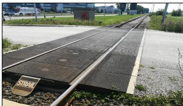
Slika 119. Prikaz stanja gumirane podloge na željezničko-cestovnom prijelazu „Buzin“
