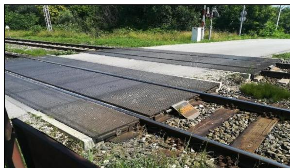
Slika 103. Prikaz stanja gumirane podloge na željezničko-cestovnom prijelazu „Utinjska“
