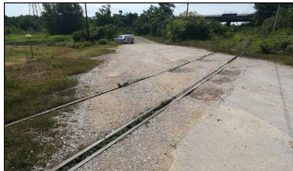
Slika 115. Prikaz stanja asfaltne podloge na željezničko-cestovnom prijelazu „Horvatova 2“
