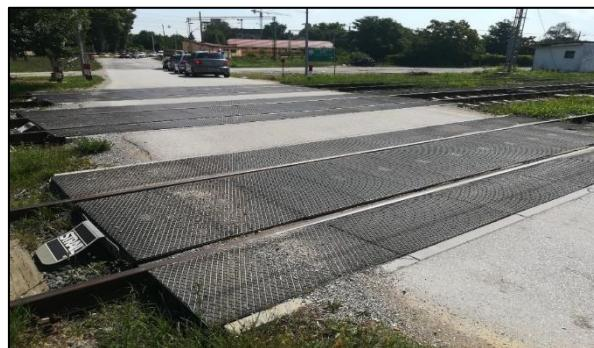
*Slika 107. Prikaz stanja gumirane podloge na željezničko-cestovnom prijelazu „Mrkšina“*
