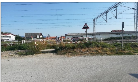
Slika 34. Željezničko-cestovni prijelaz „Treska“ iz smjera juga
