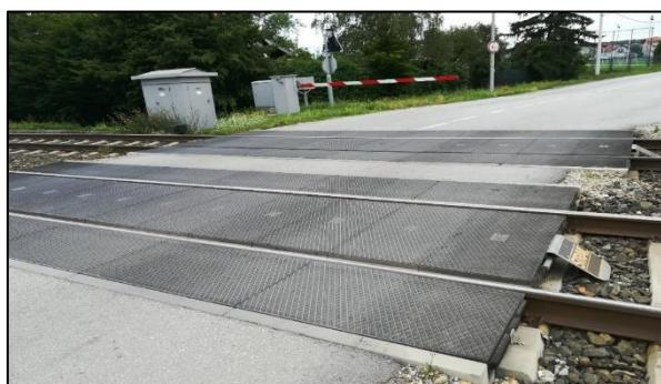
Slika 55. Prikaz stanja gumirane podloge na željezničko-cestovnom prijelazu „Dumovec“
