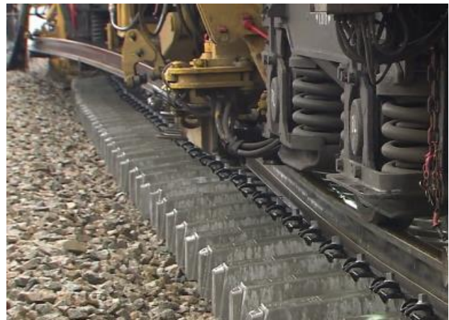
Slika 16. Postavljanje novih tračnica na nove pragove [6]
