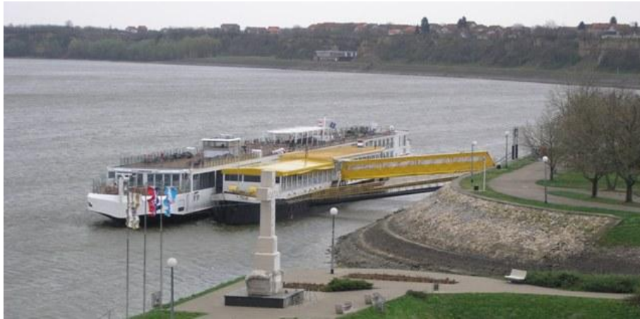
Slika 12. Pristanište za riječne putničke brodove u Vukovaru Izvor: http://www.port-authority-vukovar.hr/default.aspx?id=81 , srpanj 2015.
