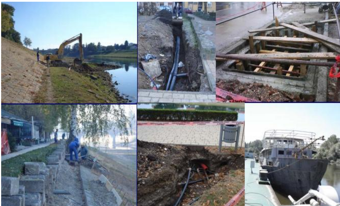
Slika 27. Započeti radovi na putničkom pristaništu Sisak Izvor: Vlahnić M. (2012.): Prezentacija: Javna ustanova Lučka uprava Sisak, Lučka uprava Sisak, Sisak
