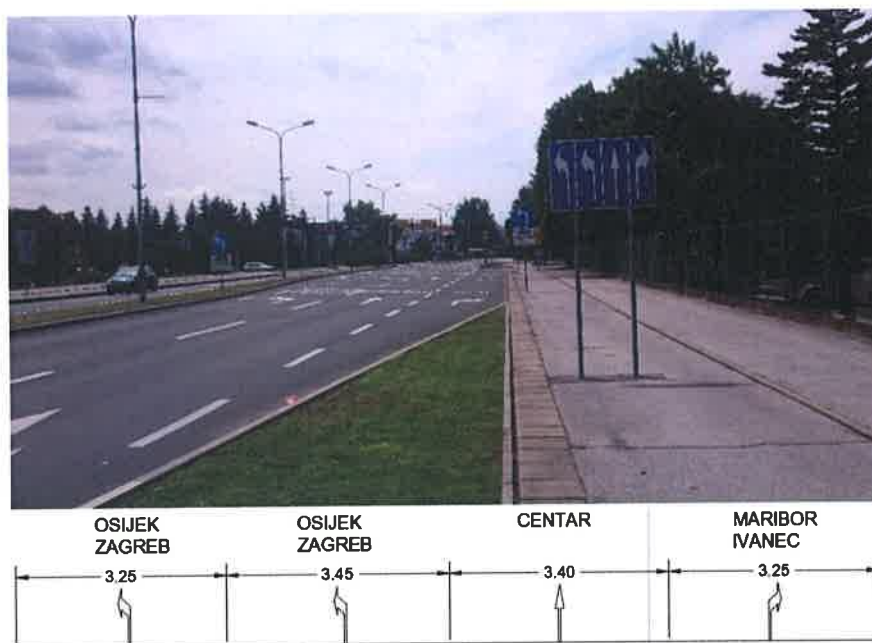
Slika 20. Privoz 4 - iz smjera sjeverozapada, Međimurska ulica
