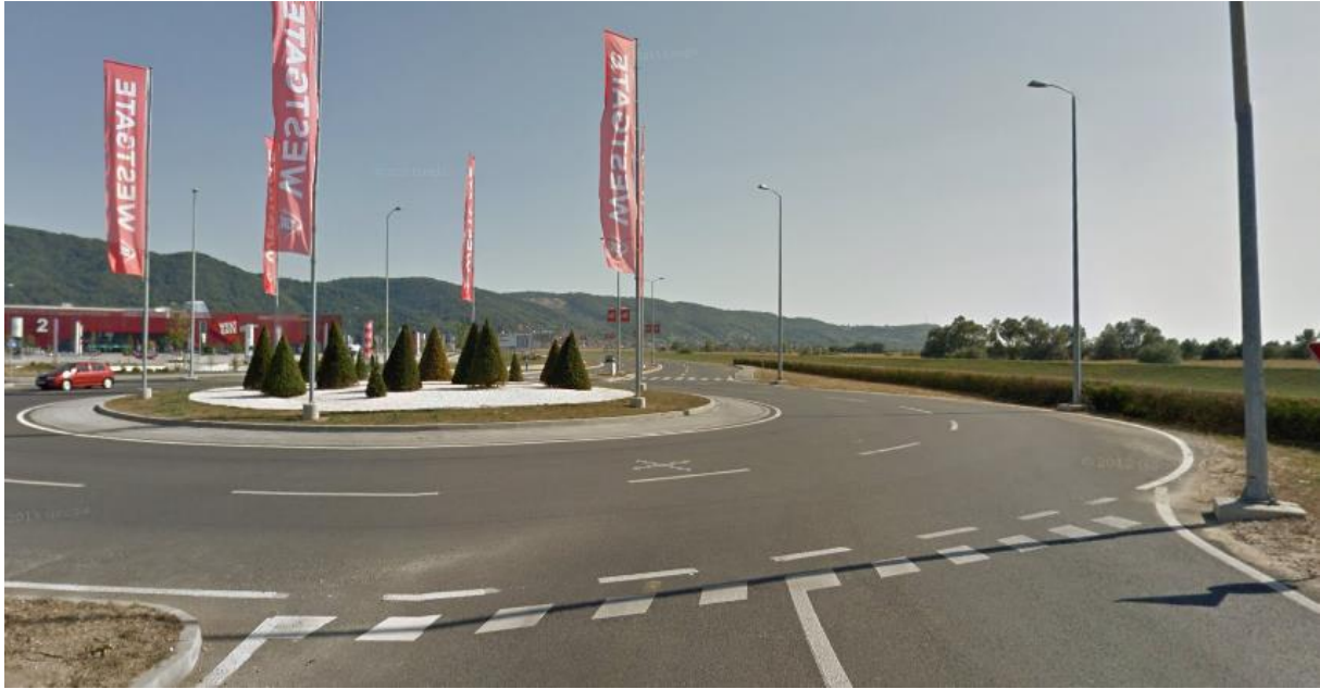
Slika 20. Pogled na „Raskrižje broj 2“ sa sjevernog privoza [7]
