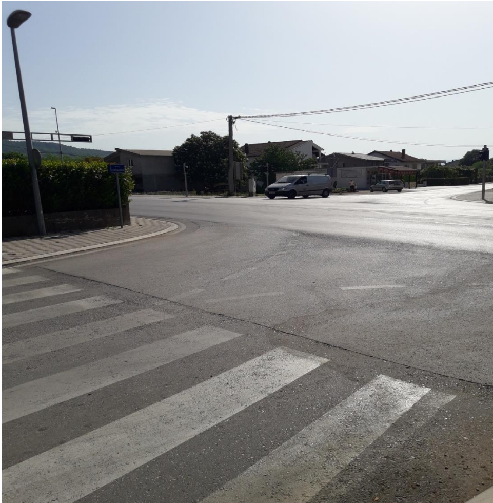
Slika 21. Nedovoljna preglednost sa zapadnog privoza na raskrižju 1
