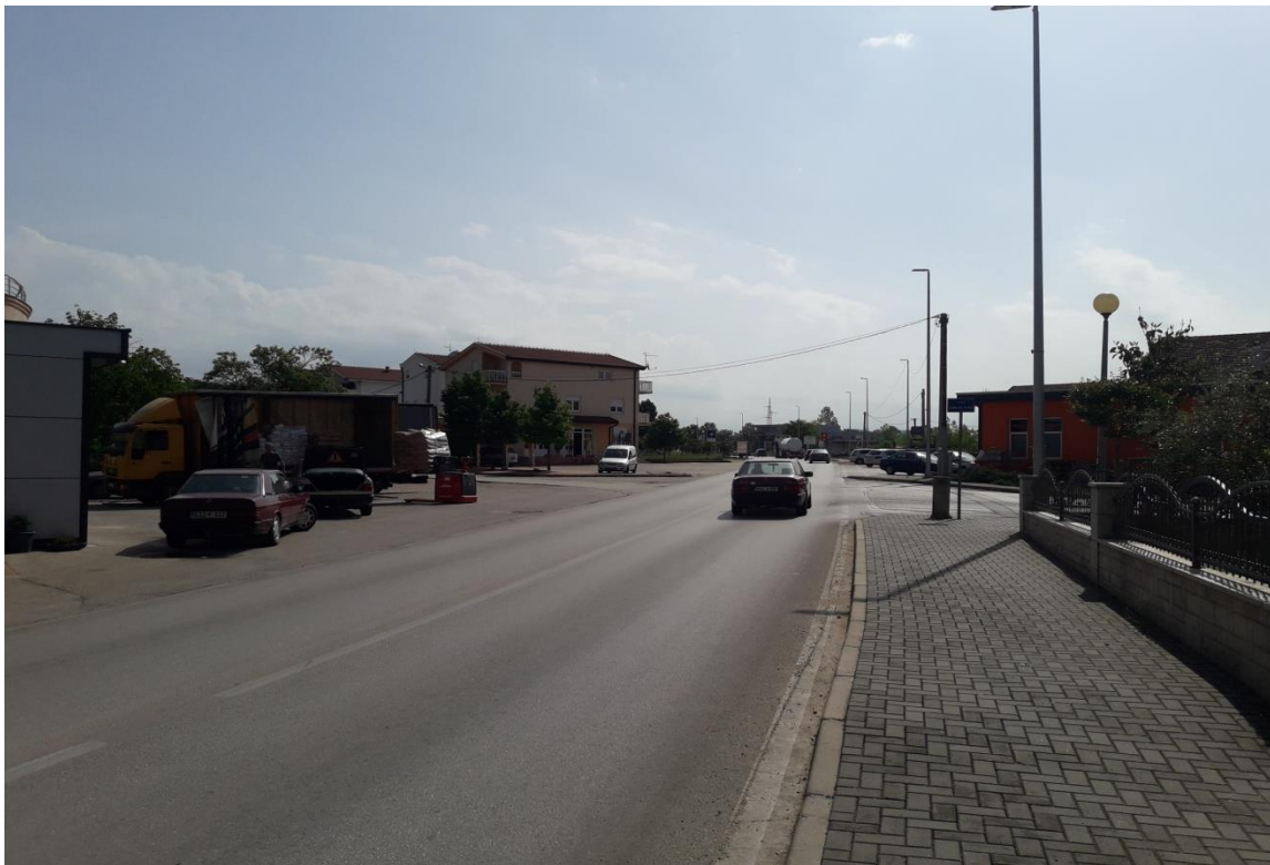
Slika 17. Pogled sa zapadnog privoza na raskrižju 3
