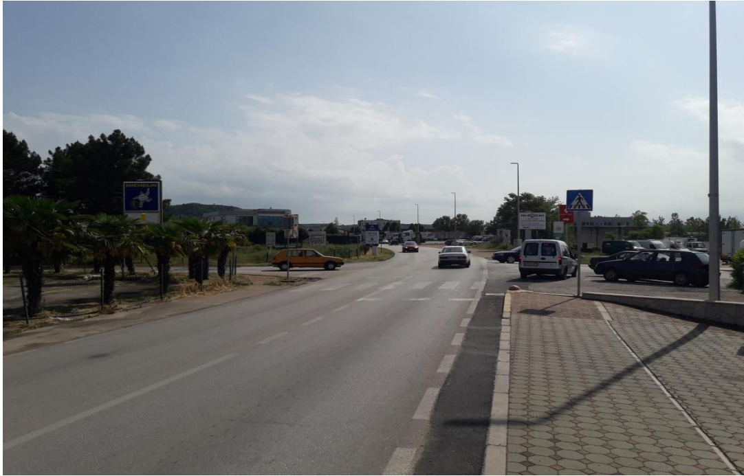
Slika 12. Pogled sa južnog privoza na raskrižju 2
