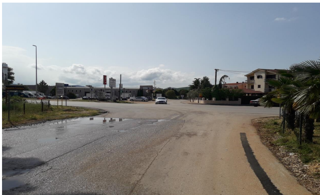
Slika 13. Pogled sa zapadnog privoza na raskrižju 2
