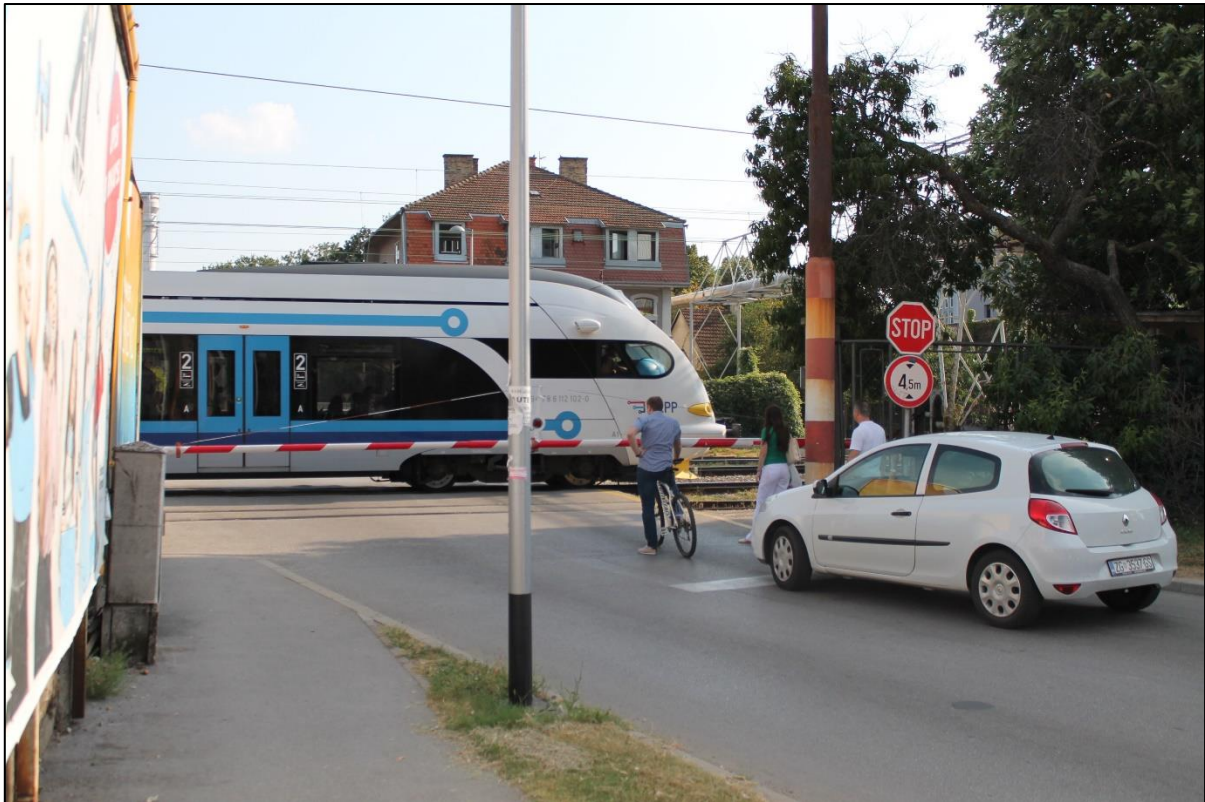
Slika 9. Željezničko-cestovni prijelaz „Vodovodna ulica“ osiguran branicima
