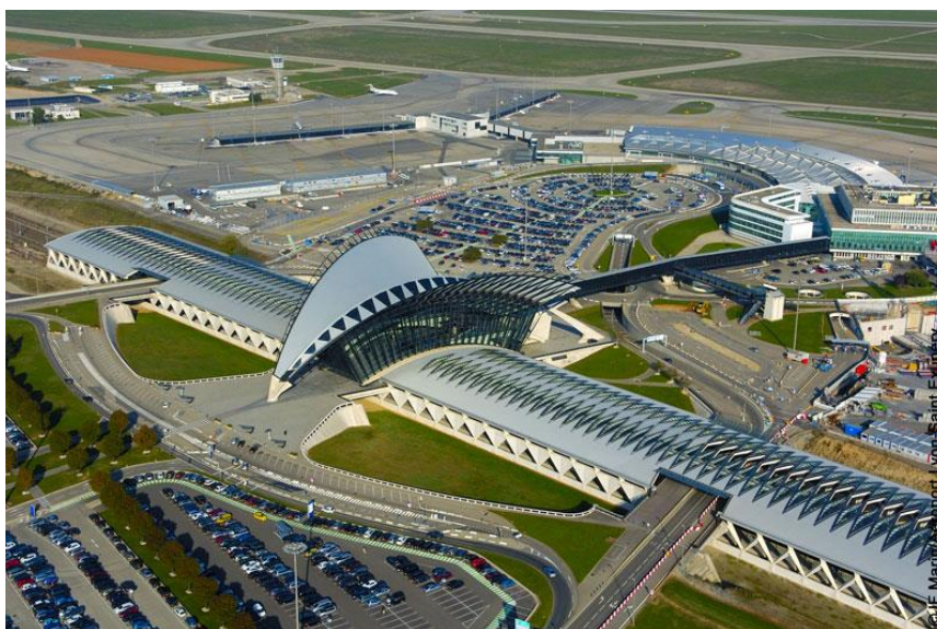
Slika 5.10. TGV stanica Lyon Saint- Exupery [40]
