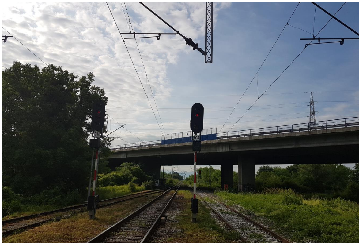
Slika 5. Izlazni signali u kolodvoru Zagreb Klara
