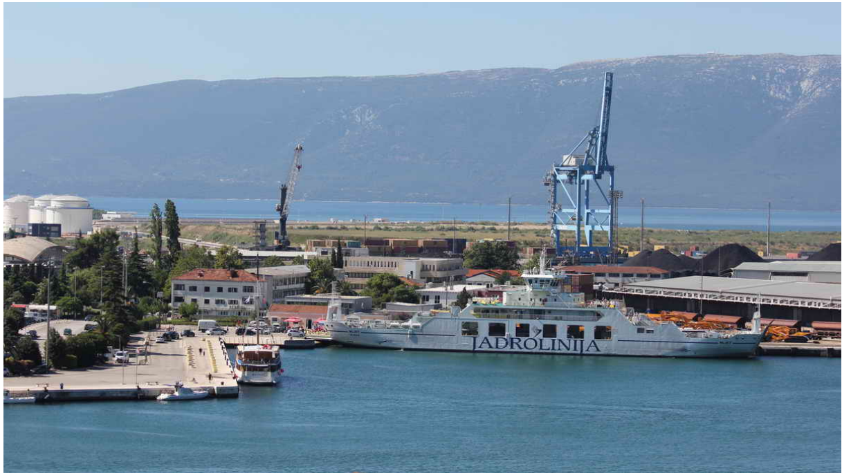
Slika 7. Putnički terminal luke Ploče
