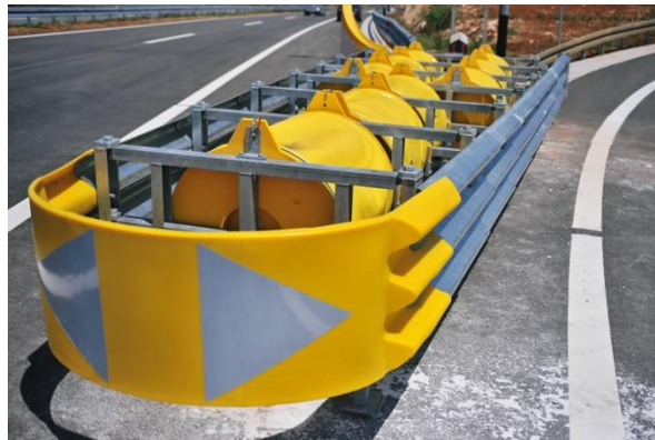
Slika 39.: Ublaživač udara [12]
