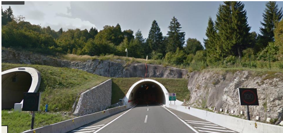
Slika 46.: Ulaz tunela Lučice [10]
