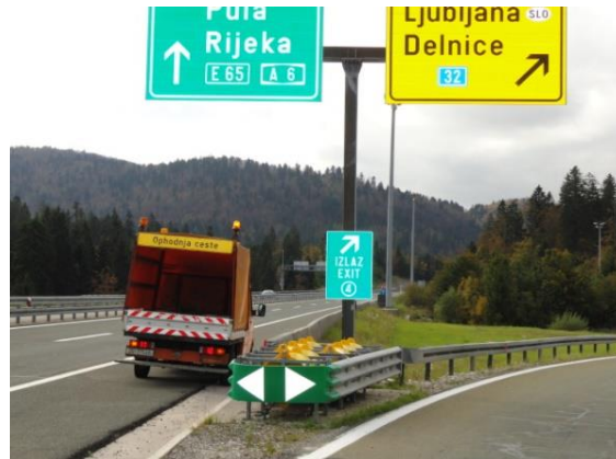
Slika 56.: Ublaživač udara - raskrižje izvan razine Delnice [19]
