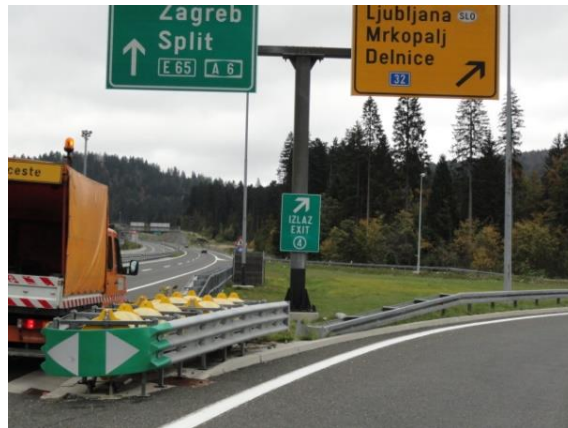
Slika 54.: Ublaživač udara – raskrižje izvan razine Delnice [19]
