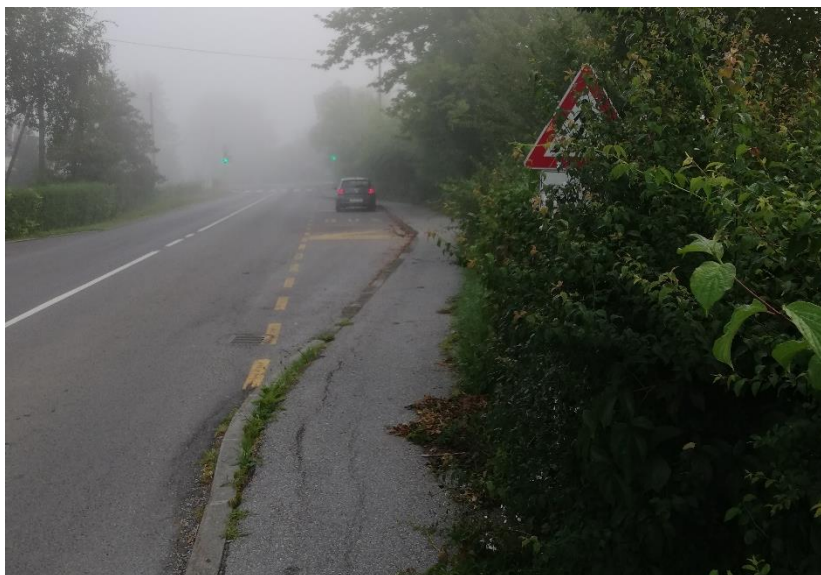
Slika 25. Nepregledan prometni znak na ulazu u naselje Mirkovec
