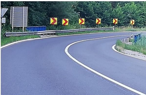
a) zaštitna ograda na objektu
