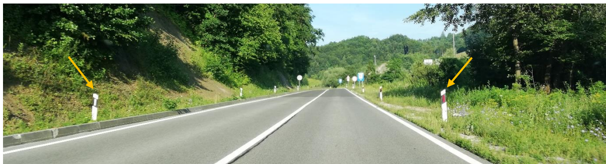
Slika 19. Prikaz postavljanja smjerokaznih stupića u pravcu
