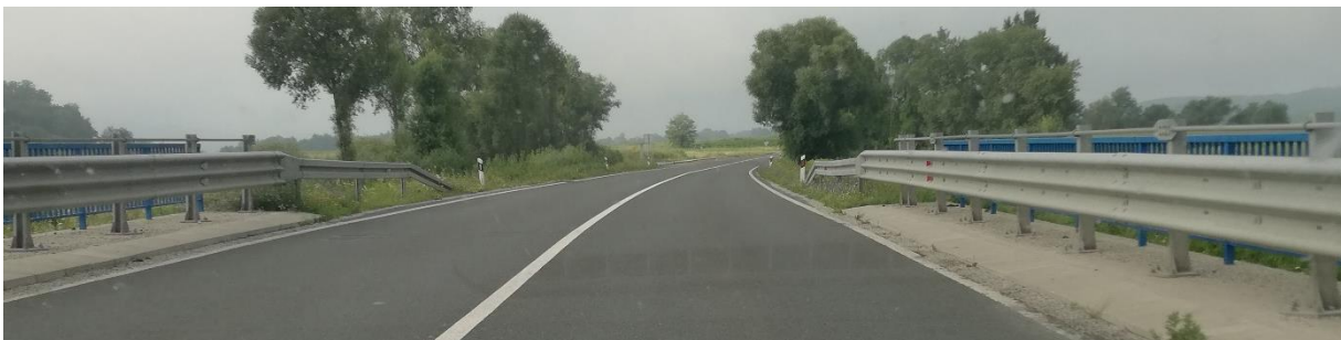
Slika 39. Zaštitna odbojna obrada na objektu u blizini naselja Luka
