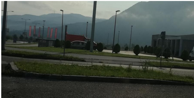
Slika 51. Privoz bez ublaživača udara i opreme za označavanje prometnog otoka
