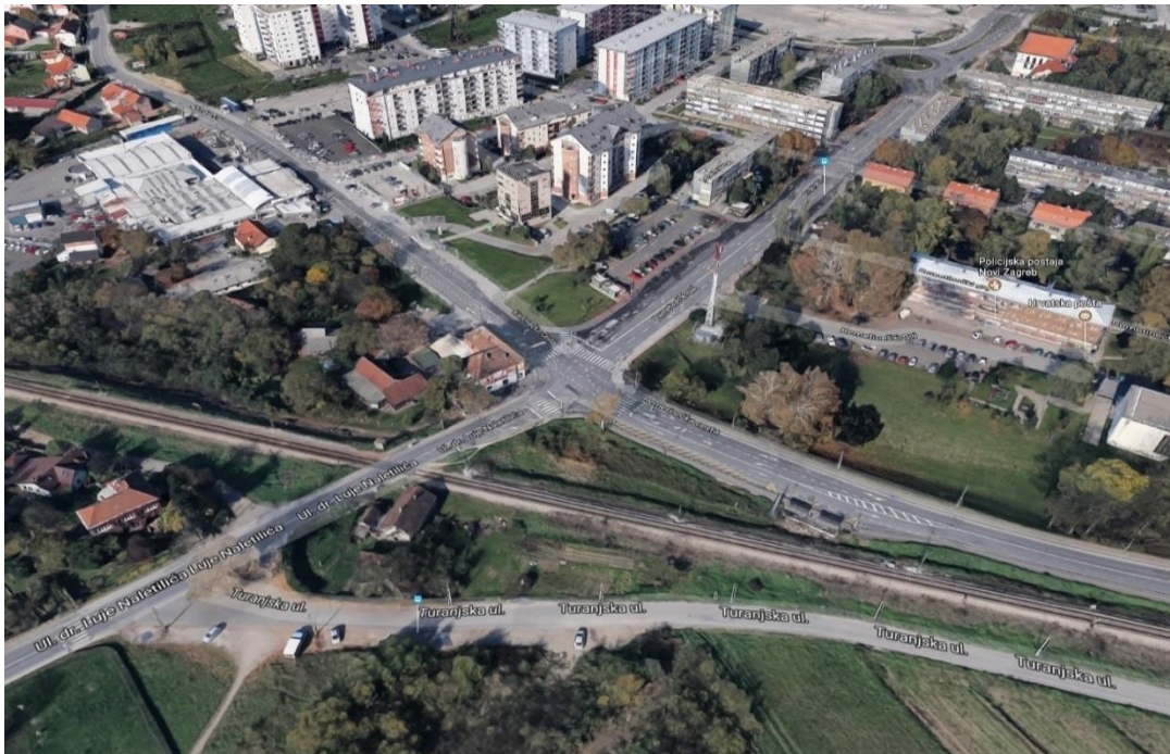
Slika 3. Raskrižje Karlovačke ulice i Ulice dr. Luje Naletilića te željezničke pruge [13]
