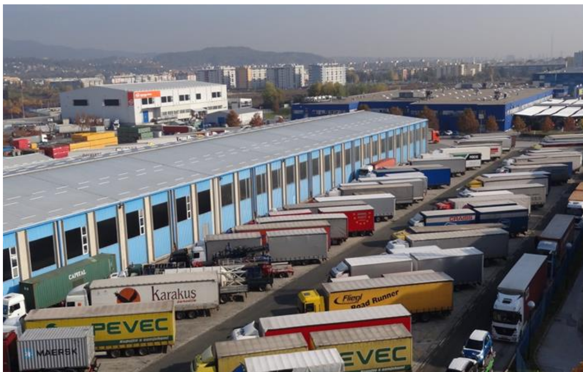
Slika 13.: Kamionski kolodvor Robni terminali Zagreb Izvor: A., Kralj: Katalog tržišnih usluga RTZ-a (prezentacija)
