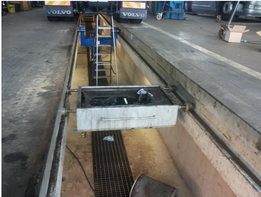
Slika 16 Posuda za ispuštanje starog ulja
