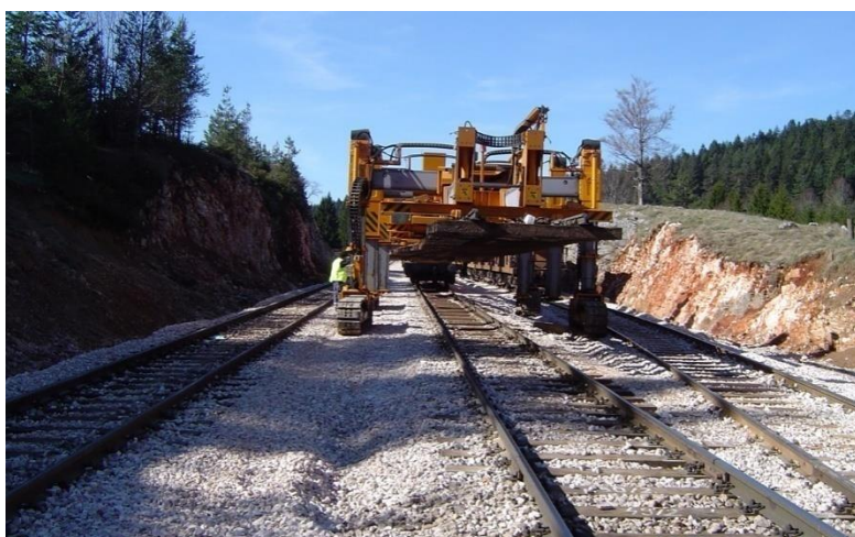
Slika 8. Višedijelni stroj za izmjenu skretnica, [8]
