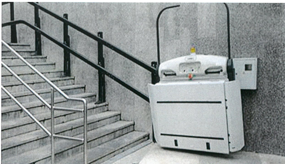
Slika 27. Dizalo za osobe smanjene i otežane pokretljivosti koje će sadržati nathodnik, [22]
