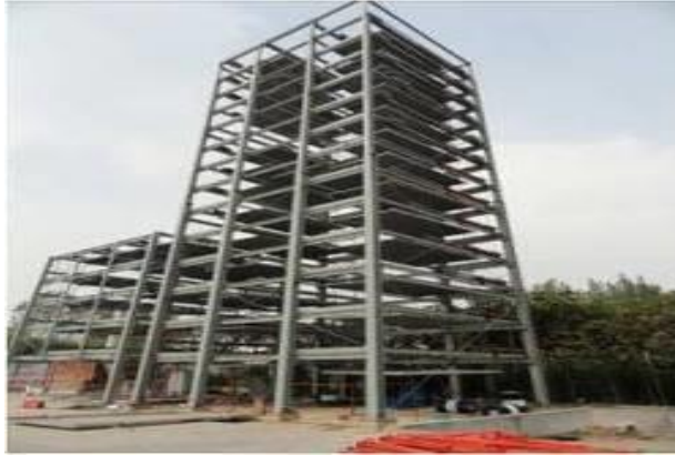
Slika 10. Toranj (dizalo) multi-floor sustav[13]
