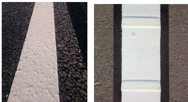
Slika 27. Prikaz neprofilirane (slika lijevo) i profilirane oznake (slika desno) izvedene plastičnim materijalima
