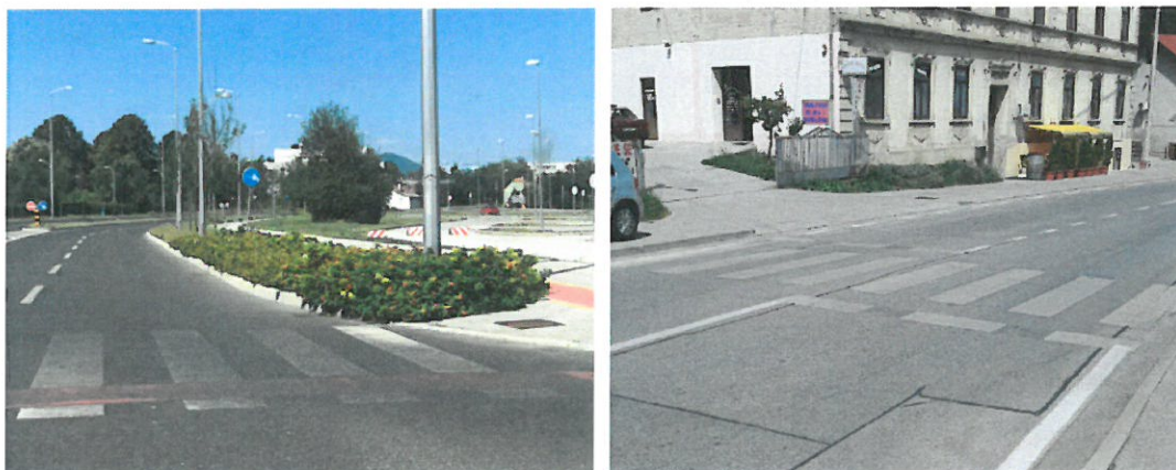
Slika 56. Primjer istrošenih oznaka na kolniku
