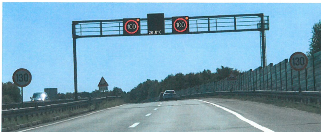
Slika 34. Primjer postavljanja promjenljivog prometnog znaka na autocesti A4
