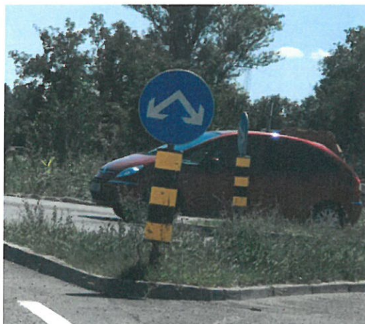
Slika 23. Primjer postavljanja ploče za označavanje prometnog otoka K06 na raskrižju D3 i ceste u smjeru Sesvete
