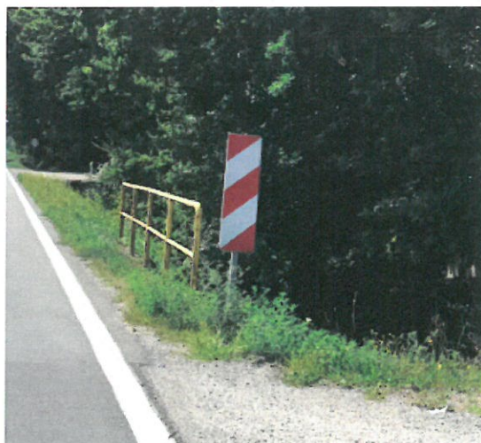
Slika 22. Primjer postavljanja ploče bočne zapreke K16 u naselju Goričica
