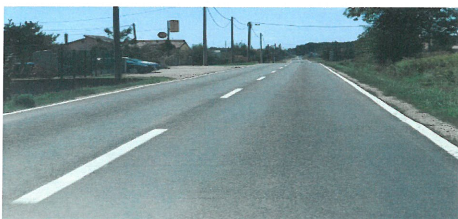
Slika 18. Primjer izvedbe uzdužne oznake na kolniku na D3 u naselju Donja Zelina izvedene kao isprekidana razdjelna i puna rubna crta
