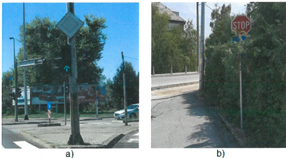
Slika 57. a) Primjer neispravnog prometnog znaka na Slavenskoj aveniji, b) Primjer neuočljivih prometnih znakova u Svetom Ivanu Zelini
