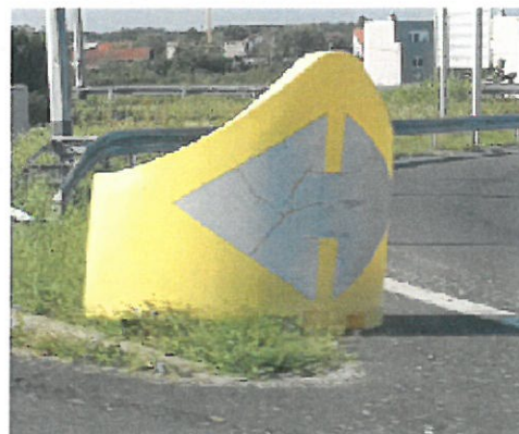
Slika 36. Primjer postavljanja ploča za označivanje prometnog otoka K07 na izlazu Zagreb istok i Kraljevečki Novaki
