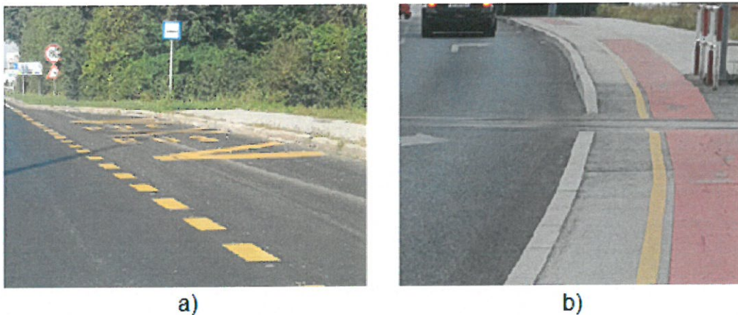
Slika 51. Primjer izvedbe oznaka na kolniku: a) oznaka H52 na Slavonskoj aveniji, b) oznaka H59 u Ulici Siniše Glavaševića
