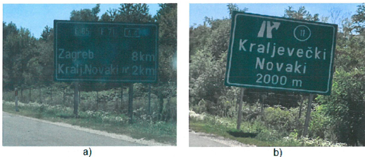
Slika 31. Primjer postavljanja znakova obavijesti za vođenje prometa na autocesti A4: a) znak D17, b) znak D01
