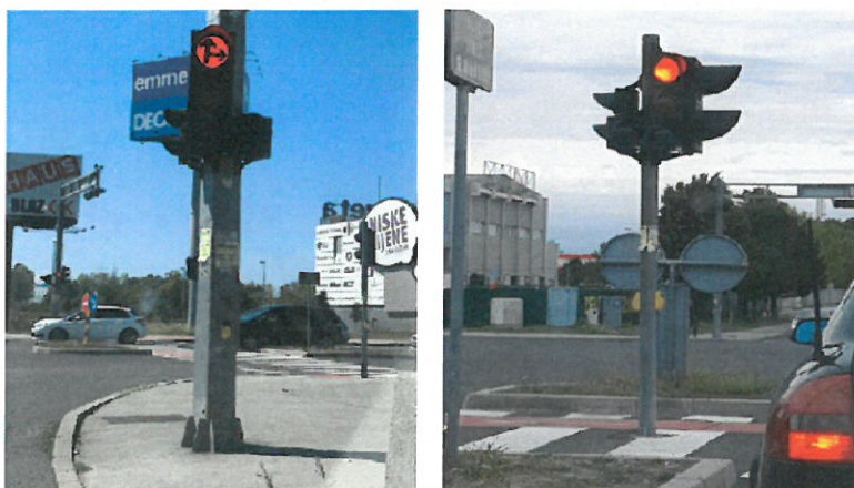
Slika 45. Primjer svjetlosnog znak za upravljanje prometom G05 na raskrižju Slavenske avenije i Ulice Siniše Glavaševića
