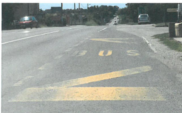
Slika 20. Primjer izvedbe oznake na kolniku H52 na autobusnoj stanici Goričica
