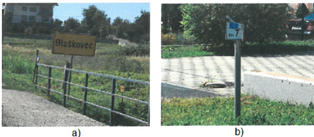
Slika 14. Primjer postavljanja znakova obavijesti na D3: a) znak C79 ispred naselja Blaškovec, b) znak C132 u naselju Belovar
