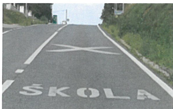
Slika 21. Primjer izvedbe oznaka na kolniku na D3: a) oznaka H42 u naselju Goričica, b) oznaka H60 u gradu Sveti Ivan Zelina
