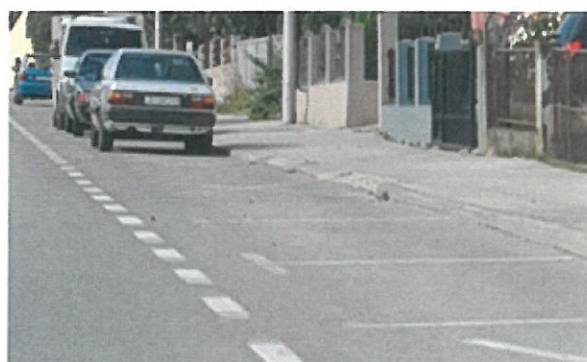
Slika 21. Primjer izvedbe oznaka na kolniku na D3: a) oznaka H42 u naselju Goričica, b) oznaka H60 u gradu Sveti Ivan Zelina
