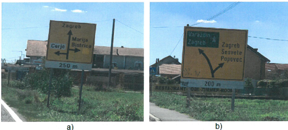
Slika 15. Primjer postavljanja znaka obavijesti za vođenje prometa D03 na D3
