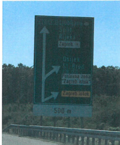
Slika 33. Primjer postavljanja znakova obavijesti za vođenje prometa D06 ispred raskrižja Zagreb istok
