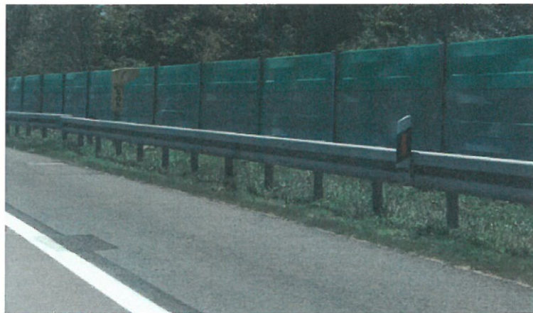
Slika 35. Primjer smjerkaznog stupića postavljenog na odbojnu ogradu na autocesti A4
