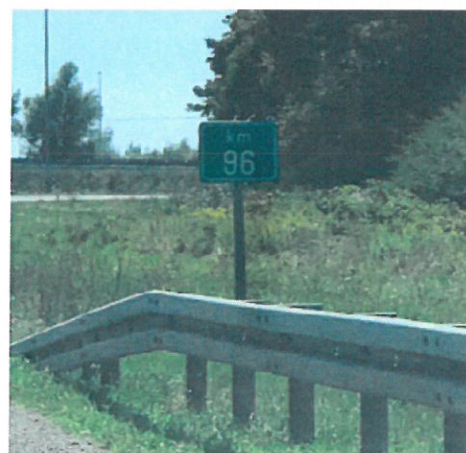
Slika 29. Primjer postavljanja znaka obavijesti C131 na autocesti A4
