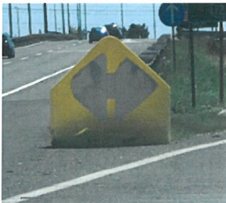
Slika 36. Primjer postavljanja ploča za označivanje prometnog otoka K07 na izlazu Zagreb istok i Kraljevečki Novaki
