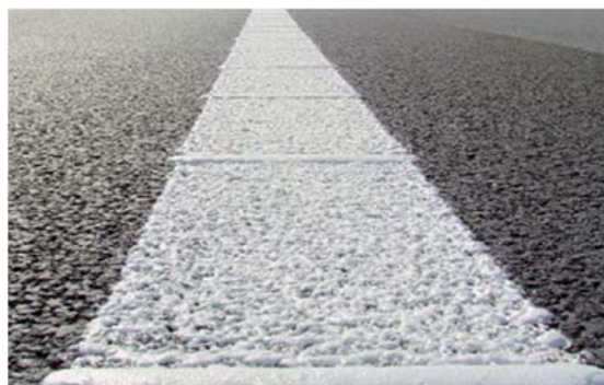
Slika 29. Oznaka na kolniku izrađena hladnom plastikom
