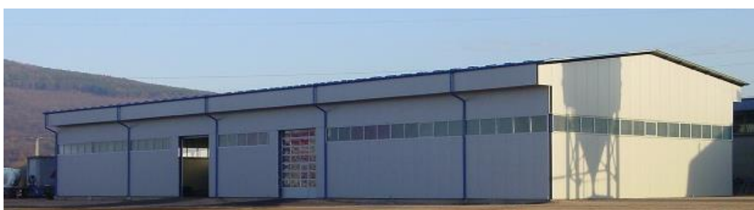
Slika 6: Prikaz zatvorenog skladišta
