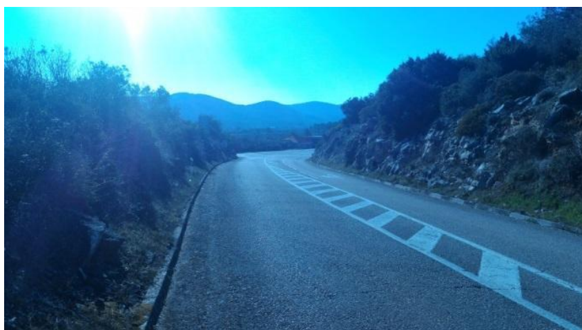
Slika 3.22. Smanjena preglednost kod nailaska na raskrižje, nailazak na raskrižje D118/Ž6222 u smjeru zapada u usjeku, trak za lijeve skretače
