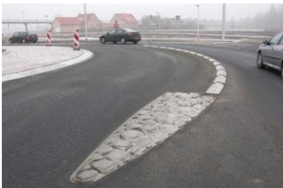
Slika 3.22. Početak montažnog rubnjaka – „špica“ [7]
