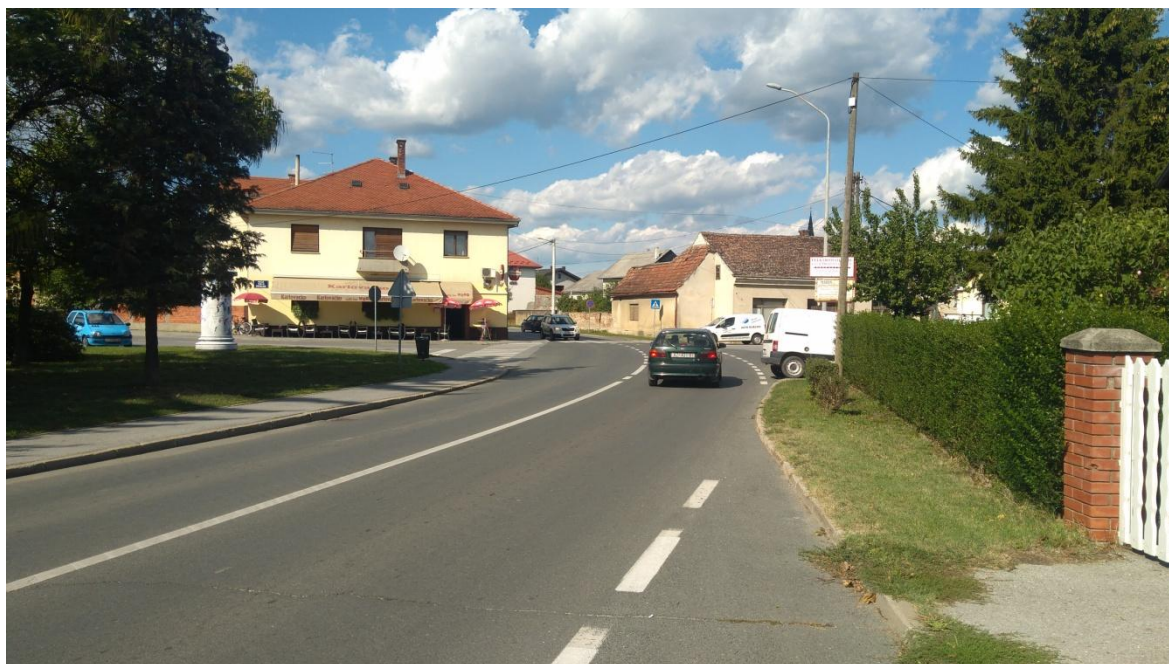
Slika 16. Pogled na raskrižje s južnog privoza
