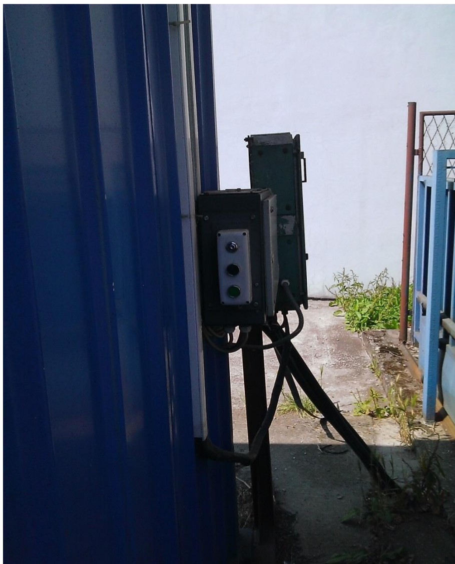
Slika 13. Uređaj za spuštanje polubranika
