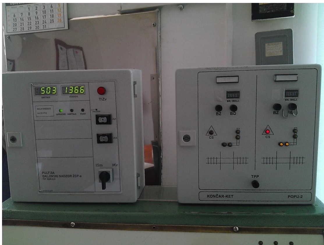
Slika 12. Uređaj za nadzor i spuštanje polubranika na ŽCP "Male Sredice"
