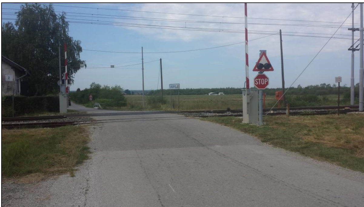
Slika 13. Željezničko-cestovni prijelaz „Turopolje“ iz smjera sjevera
