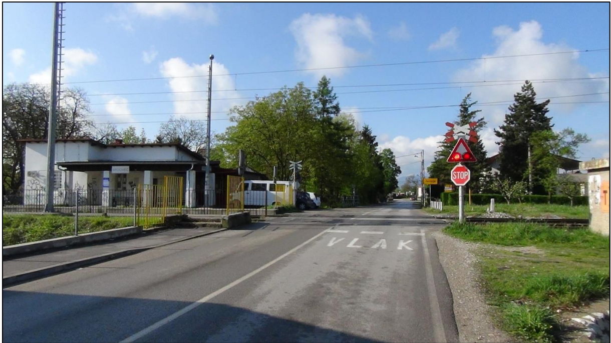
Slika 5. Željezničko-cestovni prijelaz osiguran sa svjetlosno-zvučnom signalizacijom i „Andrijinim križem“, Brdovec
