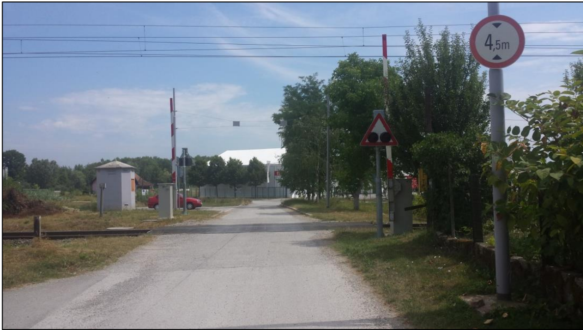
Slika 24. Pogled na željezničko-cestovni prijelaz „Lekenik I“ iz smjera juga
