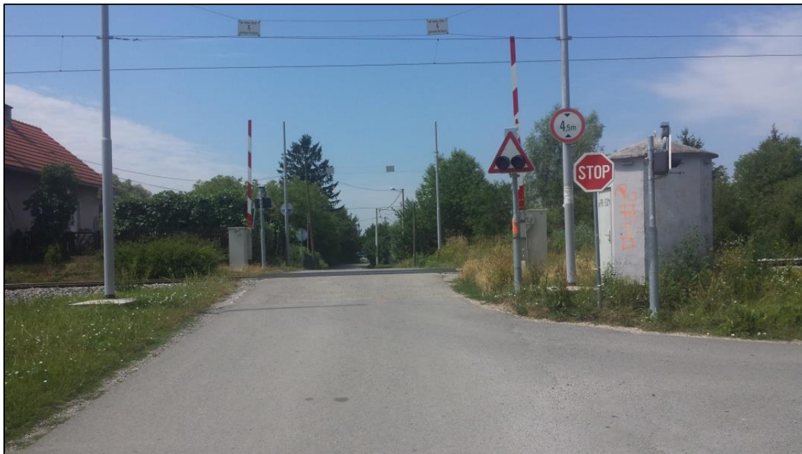
Slika 19. Željezničko-cestovni prijelaz „Lekenik“ iz smjera sjevera
