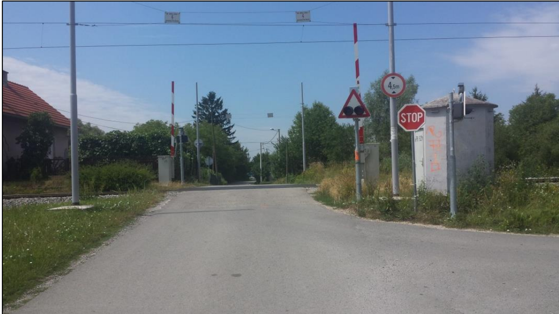
Slika 19. Željezničko-cestovni prijelaz „Lekenik“ iz smjera sjevera
