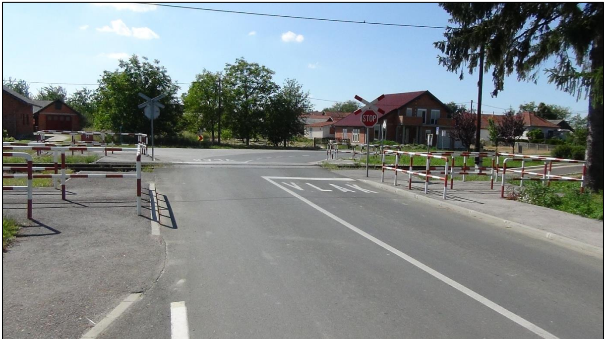
Slika 1. Pasivno osiguran željezničko-cestovni prijelaz, Novo Selo
